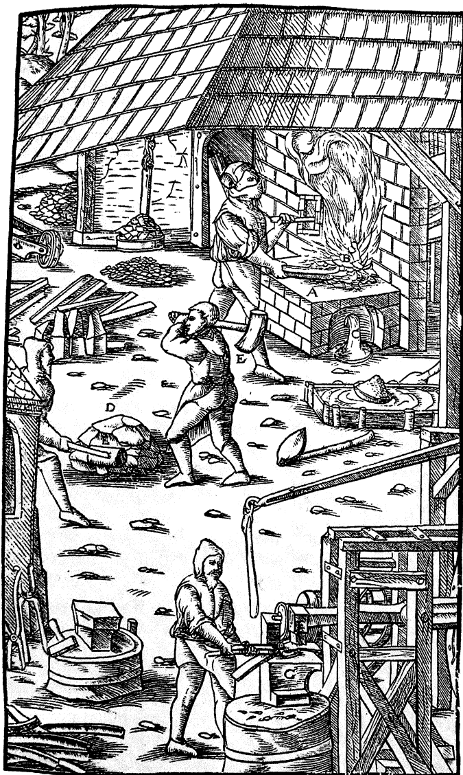
РИС. 17. Железоплавильная печь и кузница, середина XVI в.
