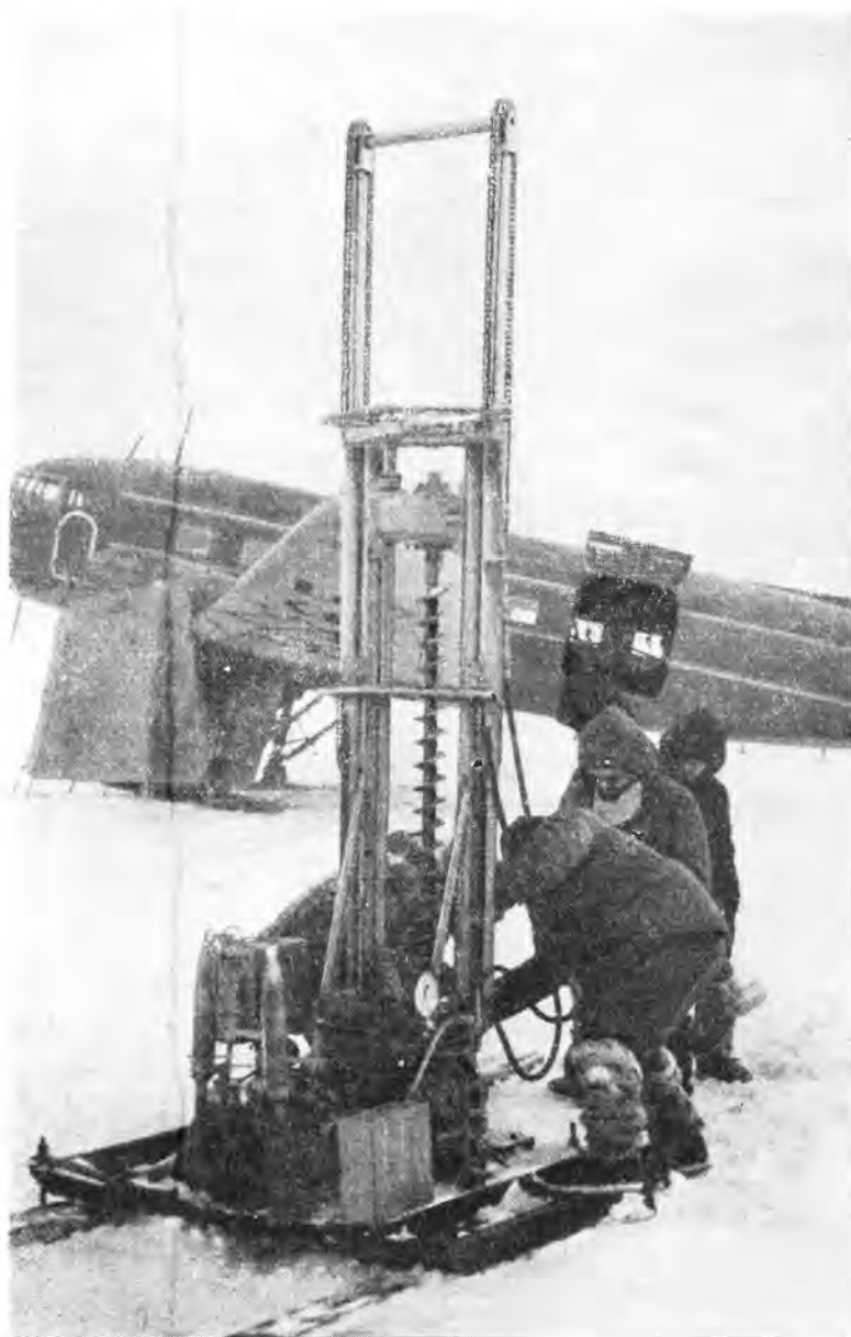
Бурение 50-метровой скважины для температурных и сейсмических зондирований при помощи портативного бурового станка
