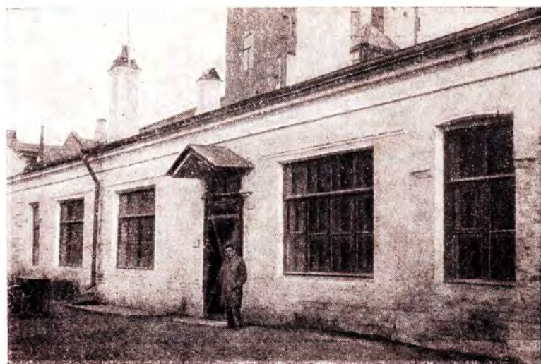
Здание Государственного астрофизического института в Москве на Новинском бульваре
