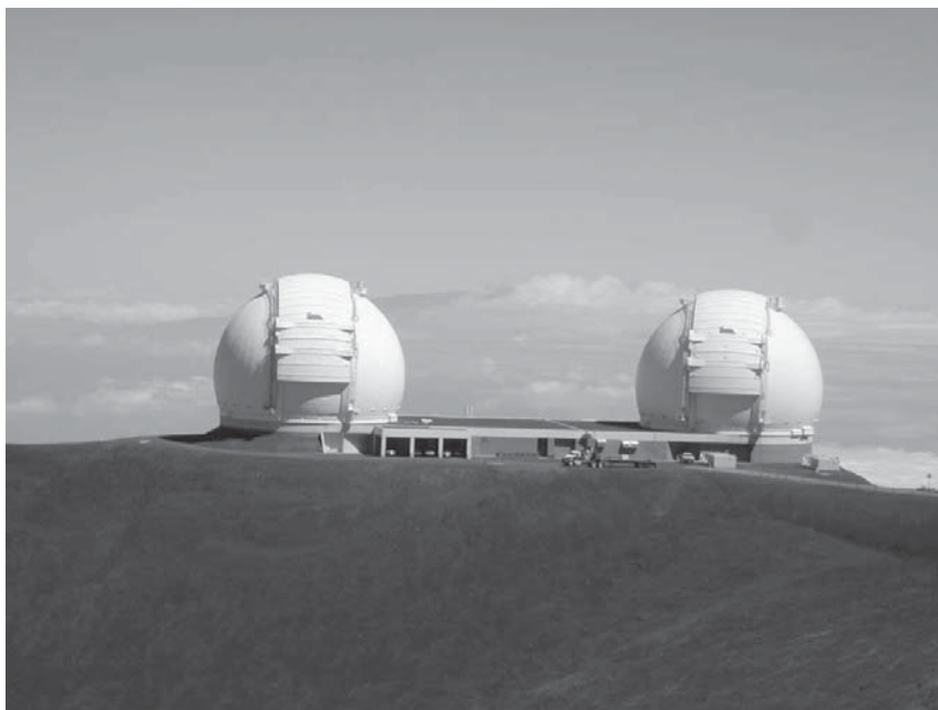
Рис. 3.36. Обсерватория «Кек» на вершине Мауна Кеа (о. Гавайи). Башни 10-м телескопов объединены лабораторным корпусом
