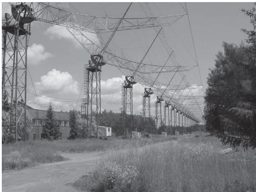
Рис. 4.7. Радиотелескоп ДКР-1000 Пушинской радиоастрономической обсерватории АКЦ ФИАН. Состоит из двух параболических цилиндров, каждый длиной 1 км. Один из них, вытянутый в направлении север–юг, неподвижно лежит на земле. Второй (на фото) вытянут в направлении восток–запад и подвижен по высоте
