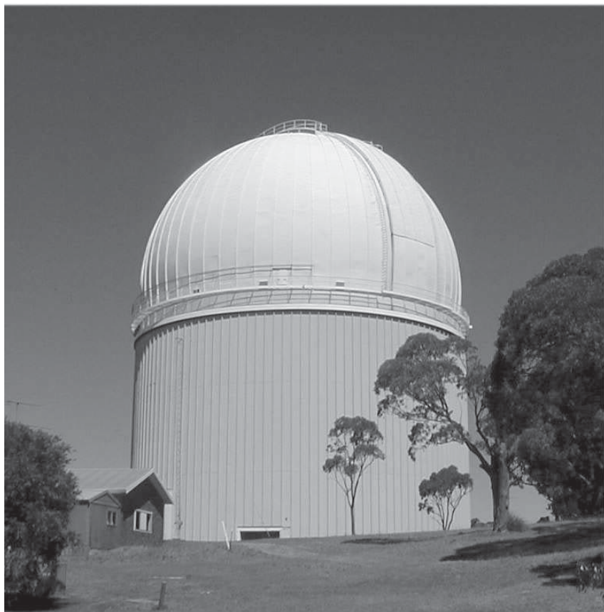
Рис. 2.14. Классическая башня оптического телескопа. В ней расположен 3,9-м рефлектор — Англо-австралийский телескоп обсерватории Сайдинг Спринг (Новый Южный Уэльс, Австралия). Купол башни имеет сдвигающееся назад забрало
