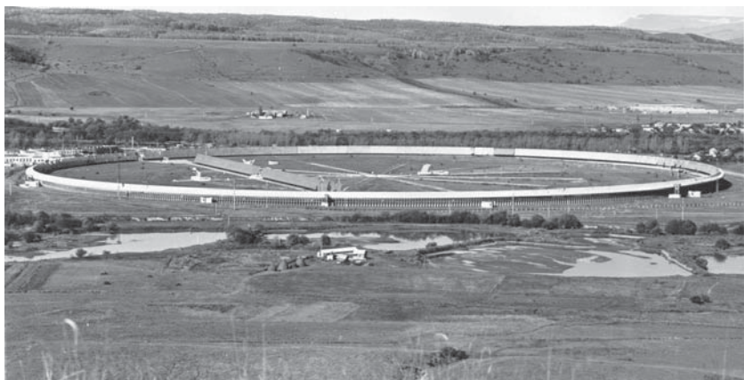
Рис. 4.6. Радиотелескоп с незаполненной апертурой РАТАН-600 (вверху) и часть его отражателя переменного профиля (слева), состоящего из отдельных алюминиевых щитов, положением каждого из которых можно управлять для придания отражателю необходимой формы. Отдельные секторы антенны могут работать как самостоятельные телескопы, а могут и совместно
