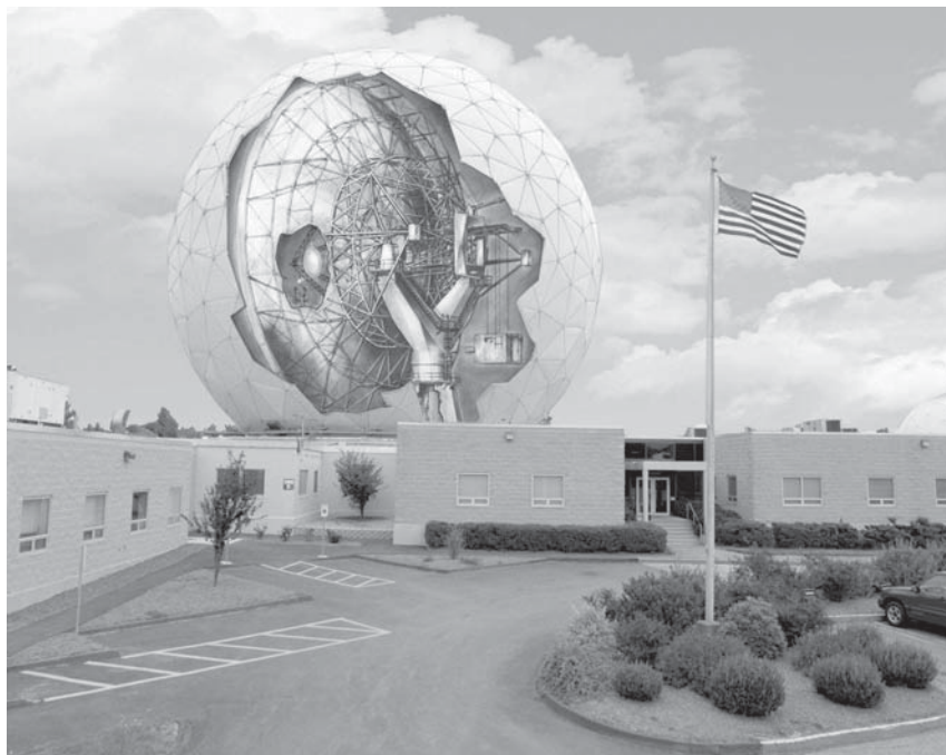
Рис. 4.2. 37-метровая антенна обсерватории Хайстек (США). Антенны умеренного размера иногда закрывают от непогоды и ветра радиопрозрачным куполом
