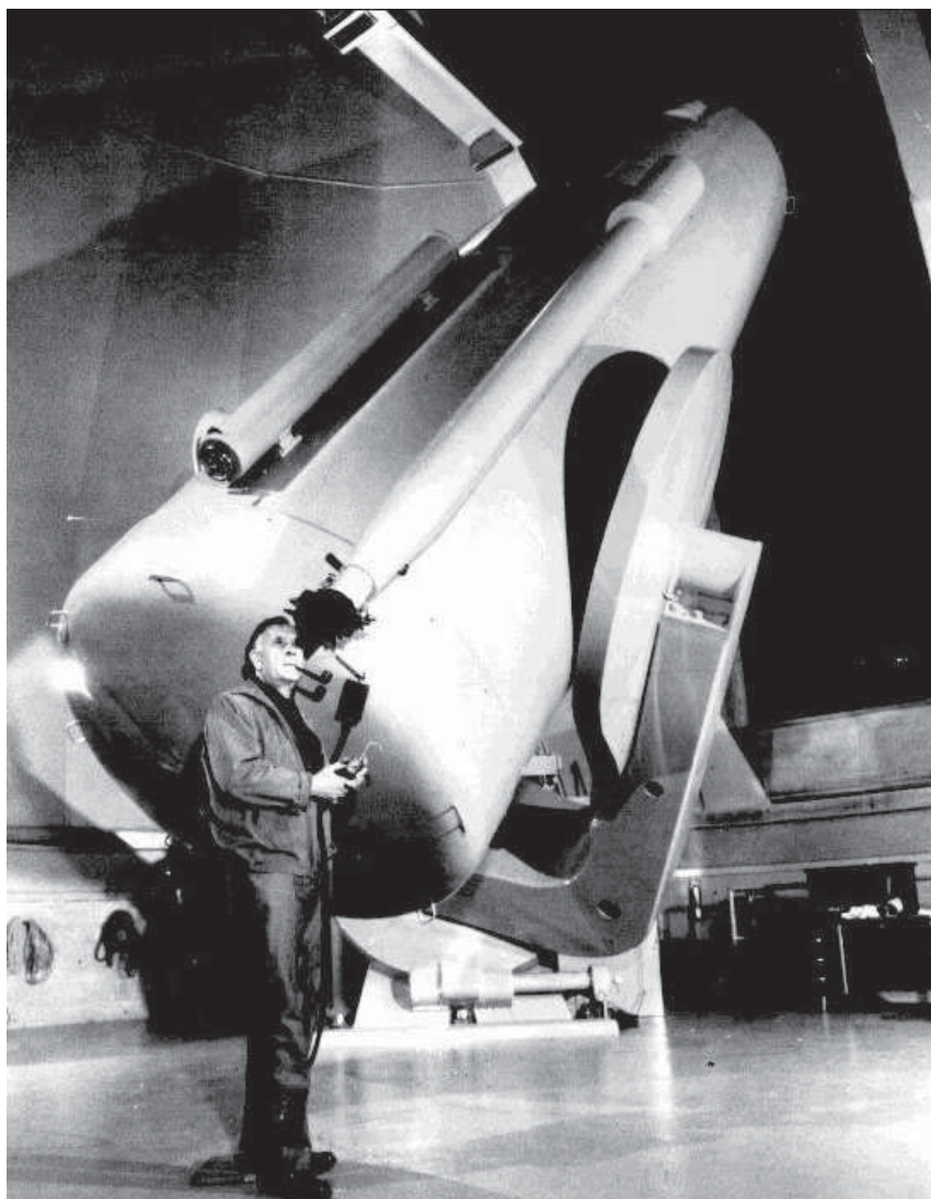
Рис. 2.7. 48-дюймовый астрограф системы Шмидта обсерватории Маунт-Паломар (Калифорния). Построен в 1948 г. и реконструирован в 1975 г. На фото Эдвин Хаббл управляет телескопом, глядя во вспомогательный инструмент — гид
