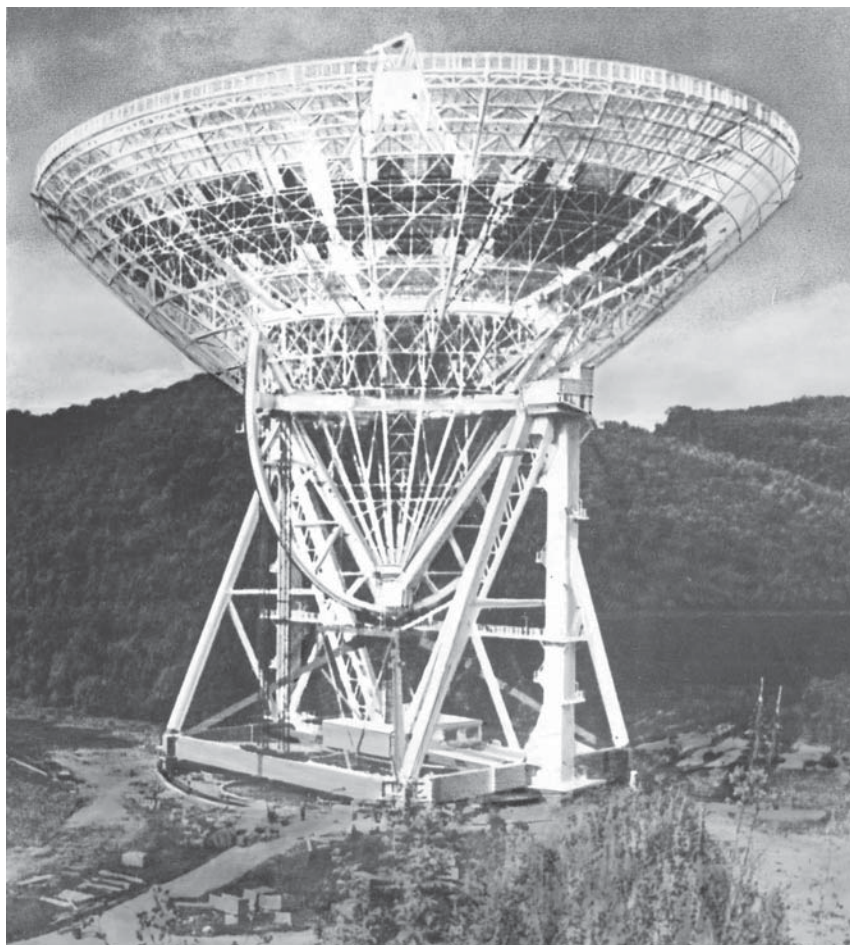
Рис. 4.4. Полноповоротный радиотелескоп в Эффельсберге (Германия, 1972 г.) диаметром 100 м. В конструкцию его параболического зеркала заложен гомологический принцип: при изменении наклона зеркало деформируется, но при этом сохраняет форму параболоида, хотя и с измененным фокусным расстоянием, которое корректируется соответствующим смещением облучателя. В результате зеркало эффективно фокусирует лучи длиной до 1,2 см, а центральная часть зеркала может строить радиоизображение на волнах до 7 мм
