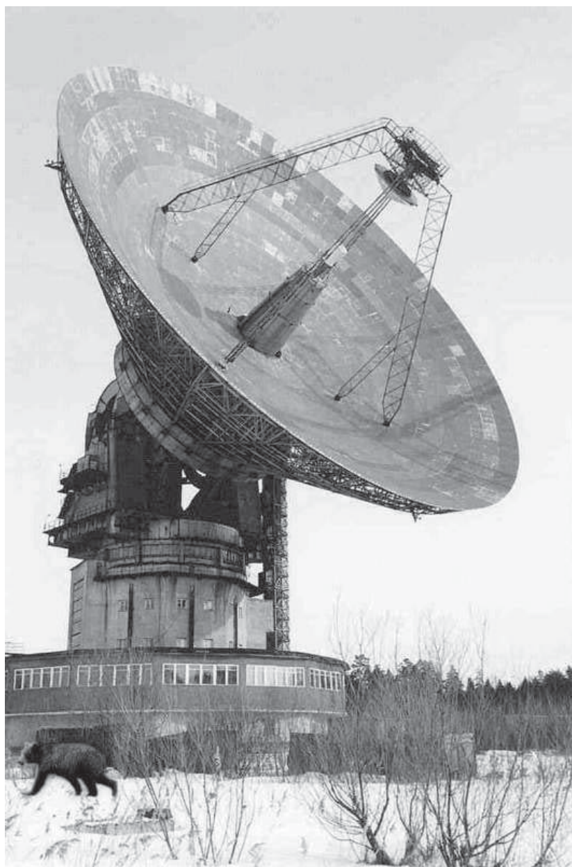
Рис. 4.3. Радиотелескоп РТ-64 Калязинской радиоастрономической обсерватории АКЦ ФИАН. Это классический полноповоротный рефлектор с параболическим зеркалом диаметром 64 м
