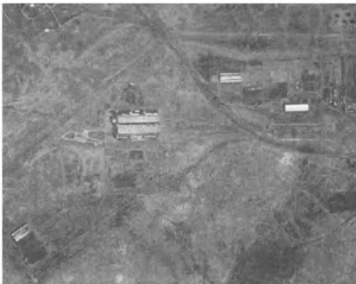
Рис. 4.13. Технический комплекс РН 8К82К «Протон К» (площадка 92, космодром Байконур)
