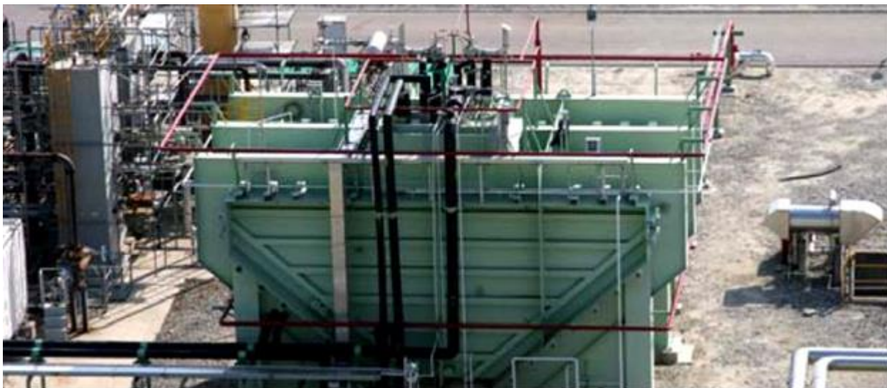
Рисунок 35 Опытный образец грузового танка КС-1 установленный для проведения тестов на терминале Incheon LNG
