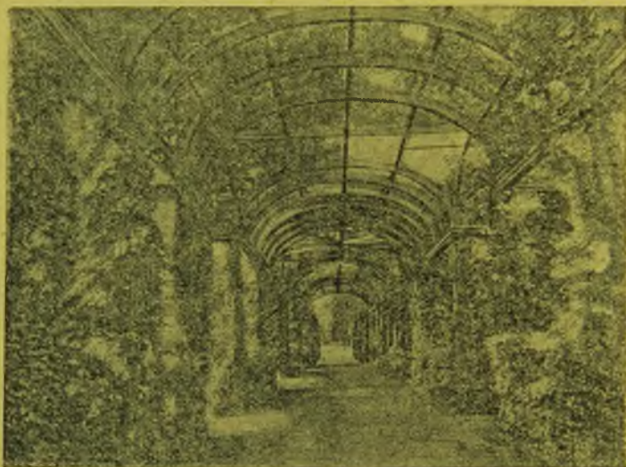
Рис. 37. Крытая аллея как форма маскировки движения по небольшому участку дороги
