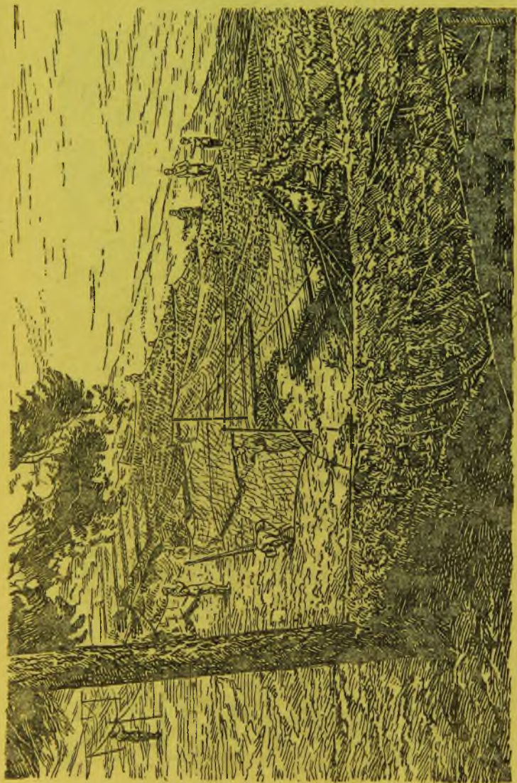
Рис. 206. Маскировка штабелей переправочного имущества — установка каркаса перекрытия
