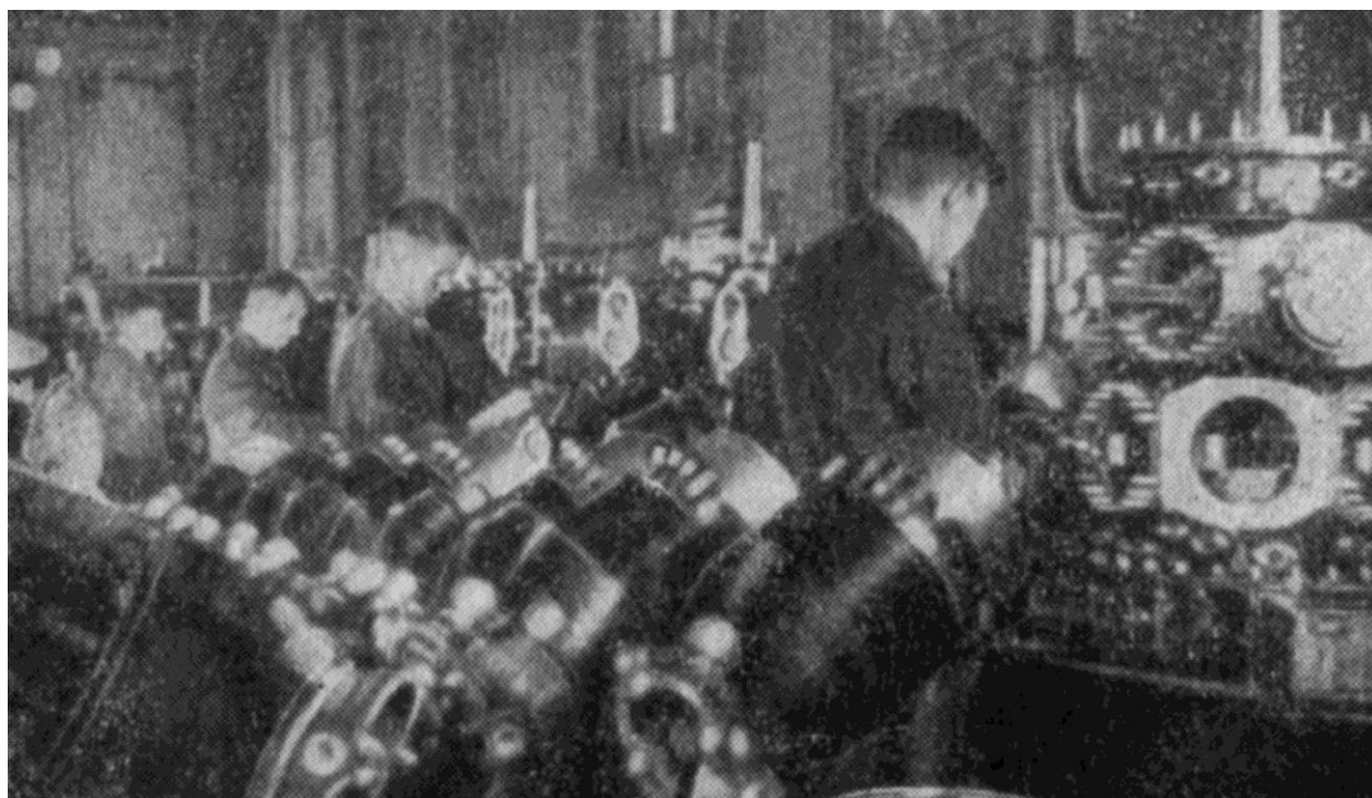
Сборка двигателей Швецова на Пермском моторостроительном заводе
