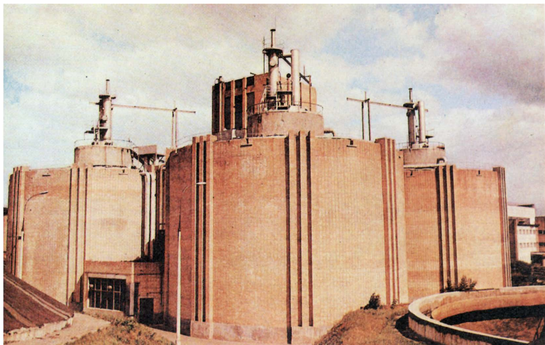
На каждом из этих метантенках на Курьяновской станции аэрации в Москве производят 12 тысяч кубометров метана в сутки. Микроорганизмы без усталости перерабатывают жидкие отходы города в ценный биогаз.
