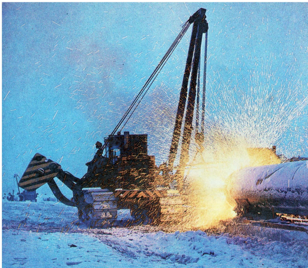
Универсальный сварочный комплекс «Север» — тоже своего рода робот. Он ползет внутри многослойных труб большого диаметра, надежно сваривая стыки газопровода в суровых условиях Заполярья.
