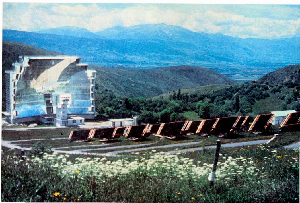
Во Франции, в Пиренеях, в Центре солнечной энергетики, много лет ведут исследования на мощных солнечных «печках» с гигантским параболическим зеркальным концентратором.
