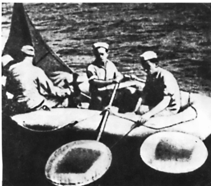
Морской опреснитель Марии Теллес, представлял собой подушку из черной материи с прозрачным пластмассовым верхом.
