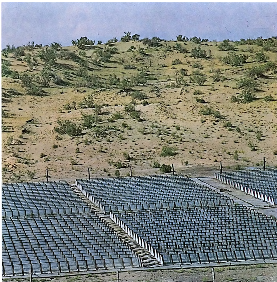
Морской опреснитель Марии Теллес, представлял собой подушку из черной материи с прозрачным пластмассовым верхом.
