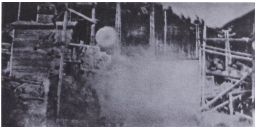
Рис. 5.23. Фотография светящейся области, образованной при закорачивании выводов электрогенератора [413]. Ср. с рис. 5.22. Воспроизводилась в работе [414].
