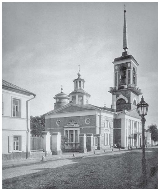
Илл. 43. Церковь св. Николая Чудотворца на Песках. 1881. Разрушена в 1932 г.
