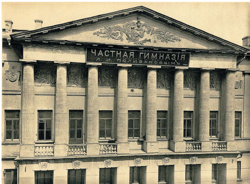
Илл. 35, 36: Здание гимназии Л. И. Поливанова (Пречистенка, д. 32). Современный вид и фотография начала XX в.
