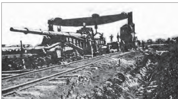
Монтаж «Колоссаль» на железнодорожную платформу
