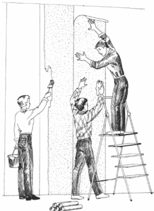
Рис. 5. Двое рабочих наклеивают на стену полосу обоев. Уже оклеено примерно половина стены. Возле оклеенной части стоит рабочий с банкой краски и кисточкой и наносит на обои слой краски.
