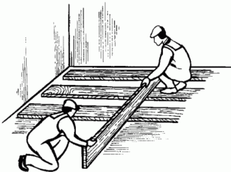
Рис. 39. Выравнивание маячных лаг.
