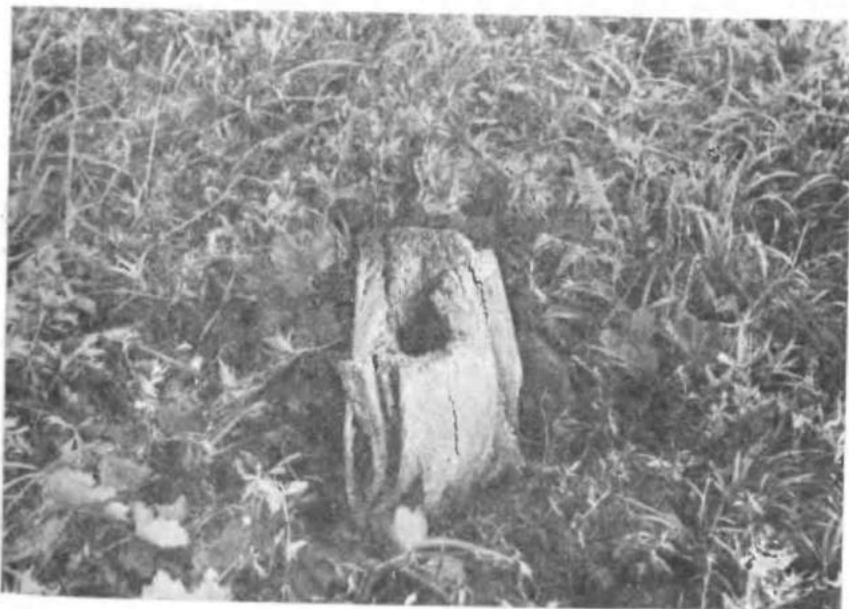
Рис. 22. Основание столба L_1 со сгнившим концом
