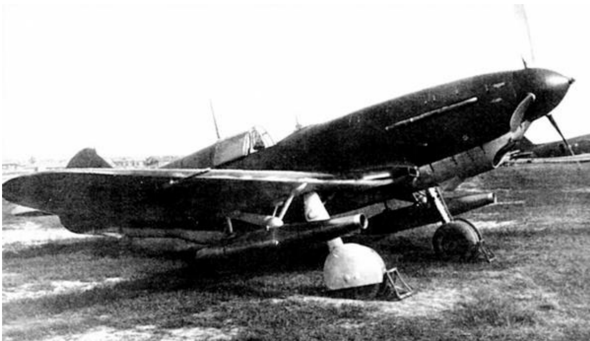
ЛаГГ-3 с дополнительными двигателями ВРД-1, 1942 г.
