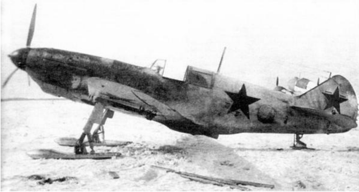
ЛаГГ-3, вооружённый РС-82 и установленный на лыжи, весна 1942 г.
