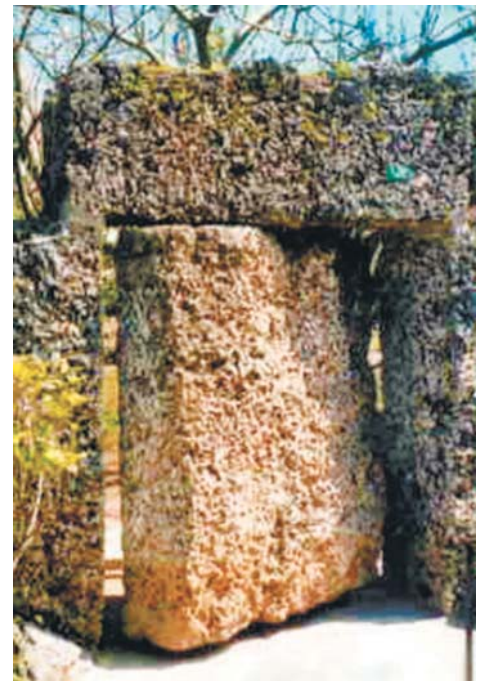
Избр. 1.59. Гигантская 9-тонная дверь по оси закреплена всего одним штырём
