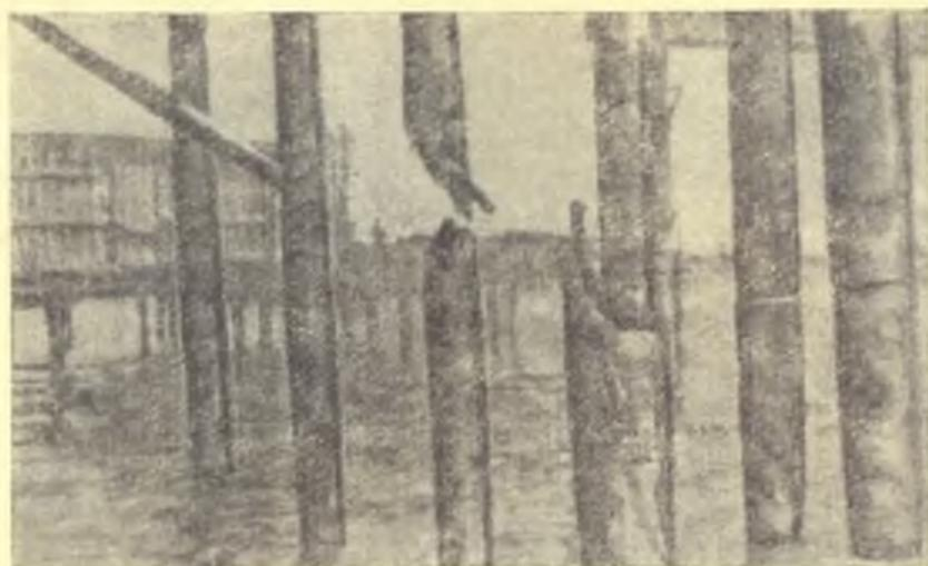
Рис. 59. Коррозионные разрушения свай морского основания в зоне периодического смачивания.
