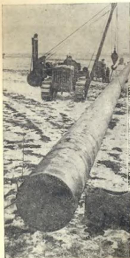
Рис. 3. Укладка труб на одном из участков строительства газопровода Шебелинка — Белгород.
