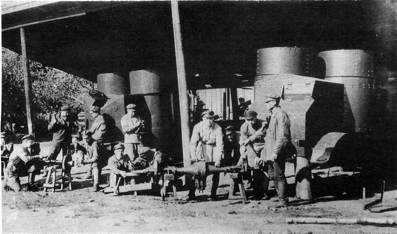
Боевые машины автобронеотряда 1-й Конной армии в ремонте. Слева — английский «Остин» 2-й серии с оборудованным в России кормовым постом управления, справа — русский «Остин». 13 сентября 1924 года.
