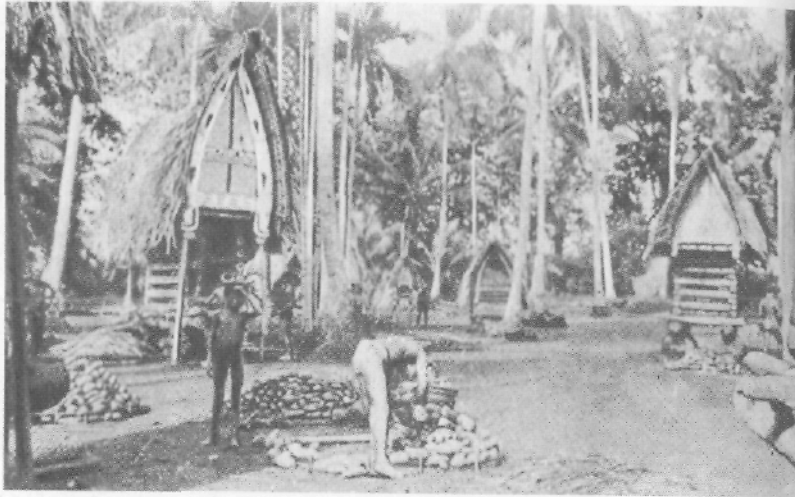
XXXIII. Заполнение хранилища ямса в Йалумугва
