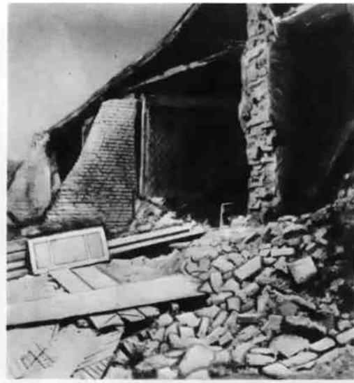
Разрушения каменных зданий горизонтальными сейсмическими толчками.
