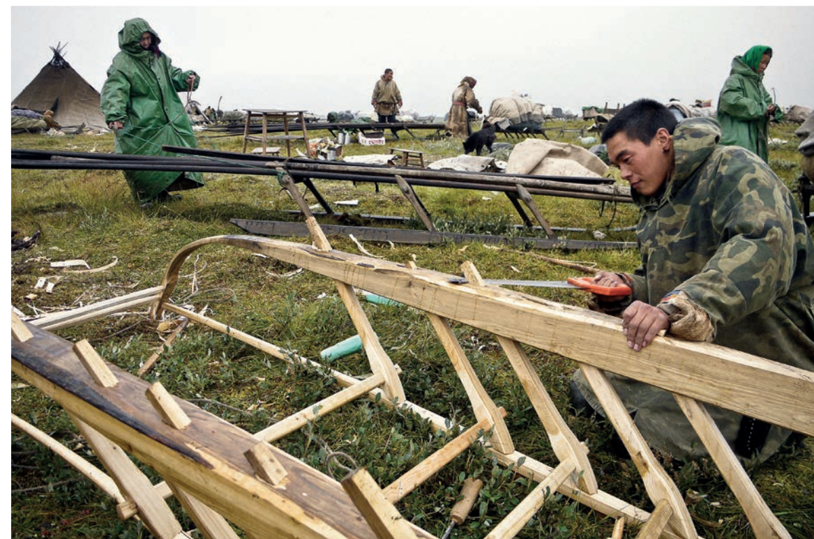
Рис. 52. Подрезка копыльев нарты
