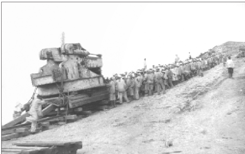
Подъем орудийных станков на кручи Ляотешана, 1904 г. (РГАВМФ. Ф. р-315. Оп. 1. Д. 191. Л. 5).
