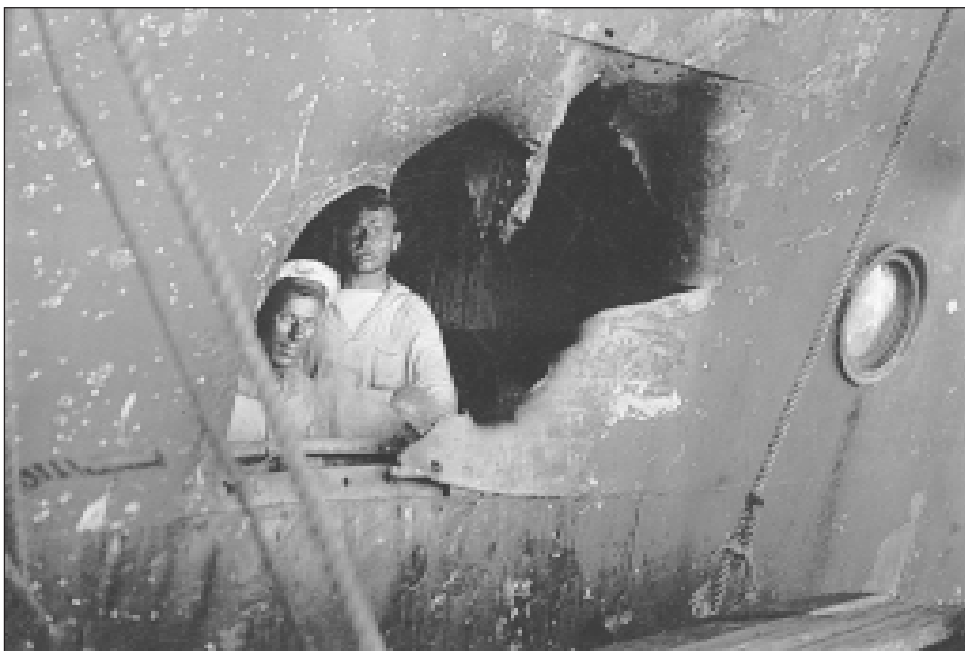
Одна из пробоин на эскадренном броненосце "Пересвет" после сражения в Желтом море 28.07. 1904 г. (РГАВМФ. Ф.24. Оп.1. Д.206. Л.16)
