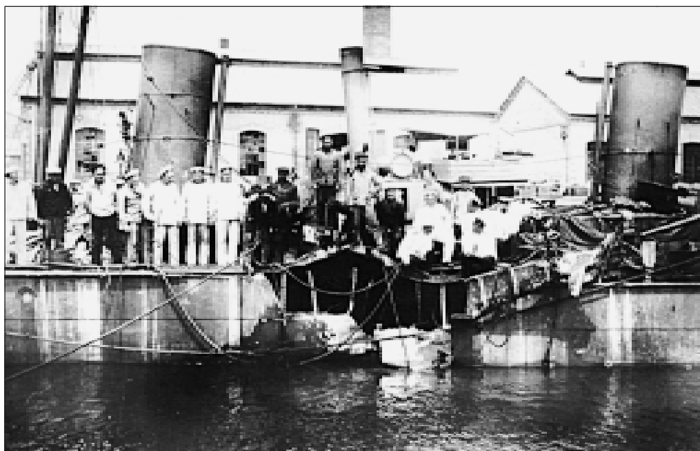
Пробоина от торпеды на миноносце «Боевой», полученная в ночь на 11.07.1904 г. в бухте Тахэ
