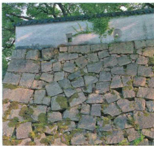
■ Беспорядочная кладка из камней со сбитыми выступами ( утикоми-хаги – ран-дзуми ). Замок Окаяма. Фотография автора.
