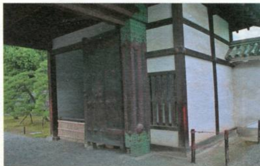
Одни из ворот замка Нидзё. С обеих сторон от ворот находятся комнатки для охраны, причем они несколько выступают за линию ворот. В этих выступах сделаны закрытые решетками окна (одно из них хорошо видно в центре фотографии), через которые можно вести фланговый огонь по атакующим ворота. Это решение основано на том же принципе, что и ёкоя . Фотография автора.
