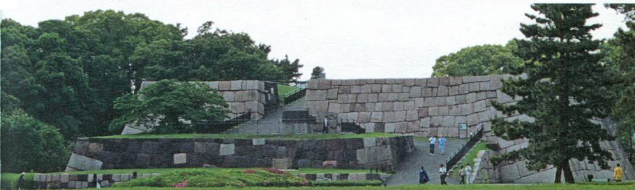
■ Кладка горизонтальными слоями из подогнанных друг к другу камней ( кирикоми-хаги – нуно-дзуми ). Основание донжона замка Эдо. Фотография автора.
