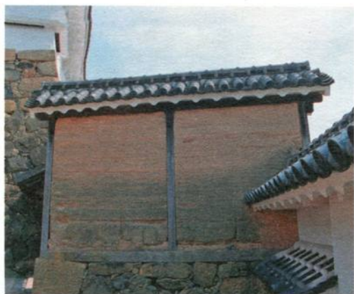
■ Абура-кабэ («масляная стена»). Замок Химэдзи. Фотография автора.
