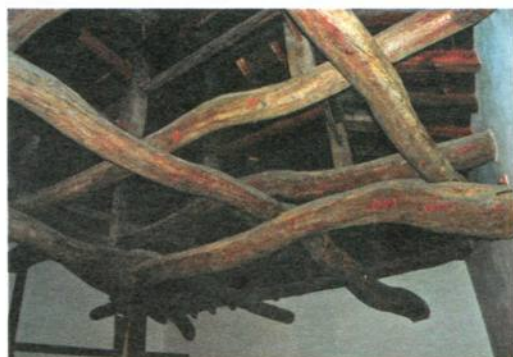
■ Балки перекрытия. Донжон замка Хиконэ. Фотография автора.
