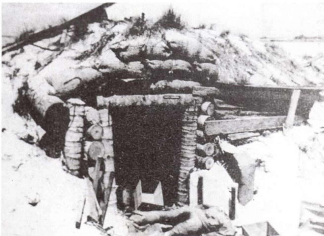
Бункер на острове Бетио, стены которого сделаны из двух рядов стволов кокосовой пальмы. Простенки заполнены песком. Крыша из мешков с песком достигает 120 см в толщину. Та сторона бункера, которая обращена к острову, только частично засыпана песком, а обращенная к морю сторона засыпана песком на высоту 180 см. На стороне обращенной к морю, японцы изготавливали барьеры для защиты выходов или даже индивидуальных стрелковых гнезд от взрывов, но в этом бункере такая защита отсутствует.
