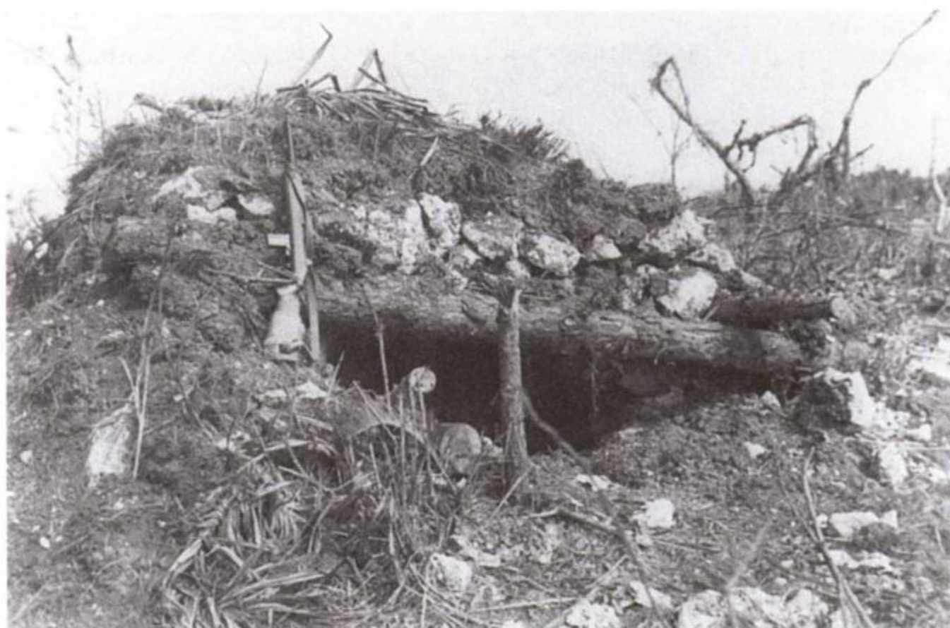
Этот дзот для легкого пулемета на острове Окинава состоит из бревен, камней и земли. Это типичная конструкция, обычно размещаемая на склонах хребтов. Такой дзот фактически невозможно заметить до тех пор, пока из него не открывали огонь. Этот дзот был разрушен выстрелом из базуки. Карabin М1 слева от отверстия положен для масштаба.
