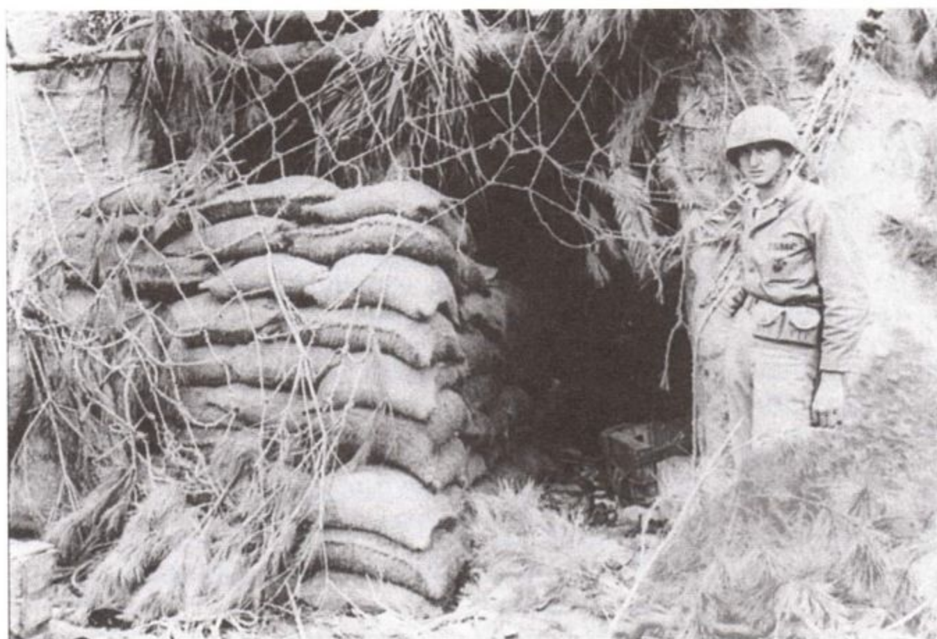
Вход в этот склад-землянку на острове Окинава хорошо защищен мешками с песком. В прошлом эти мешки использовались для перевозки риса. Маскировочная сетка с вплетенной в нее растительностью отброшена в сторону, открывая вход.
