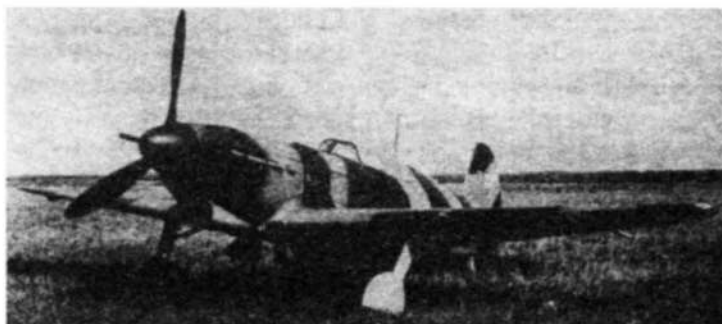
Як-7-37 был вооружен мощной 37-мм пушкой
