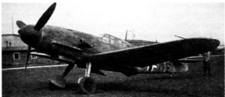
«Фридрих» отличался от ранних модификаций Bf 109 улучшенными аэродинамическими формами
