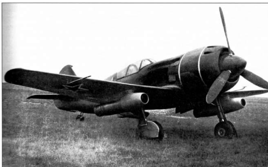
ПВРД-430 под крылом самолета «164»
