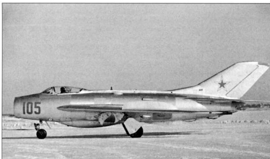
СМ-20 — самолет-имитатор крылатой ракеты Х-20 мог эксплуатироваться с обычного аэродрома
