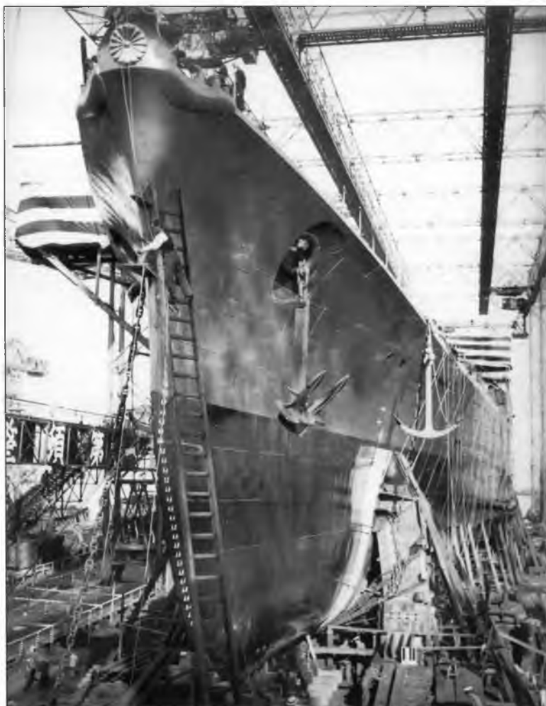
Подготовка к спуску на воду крейсера «Китапо»
