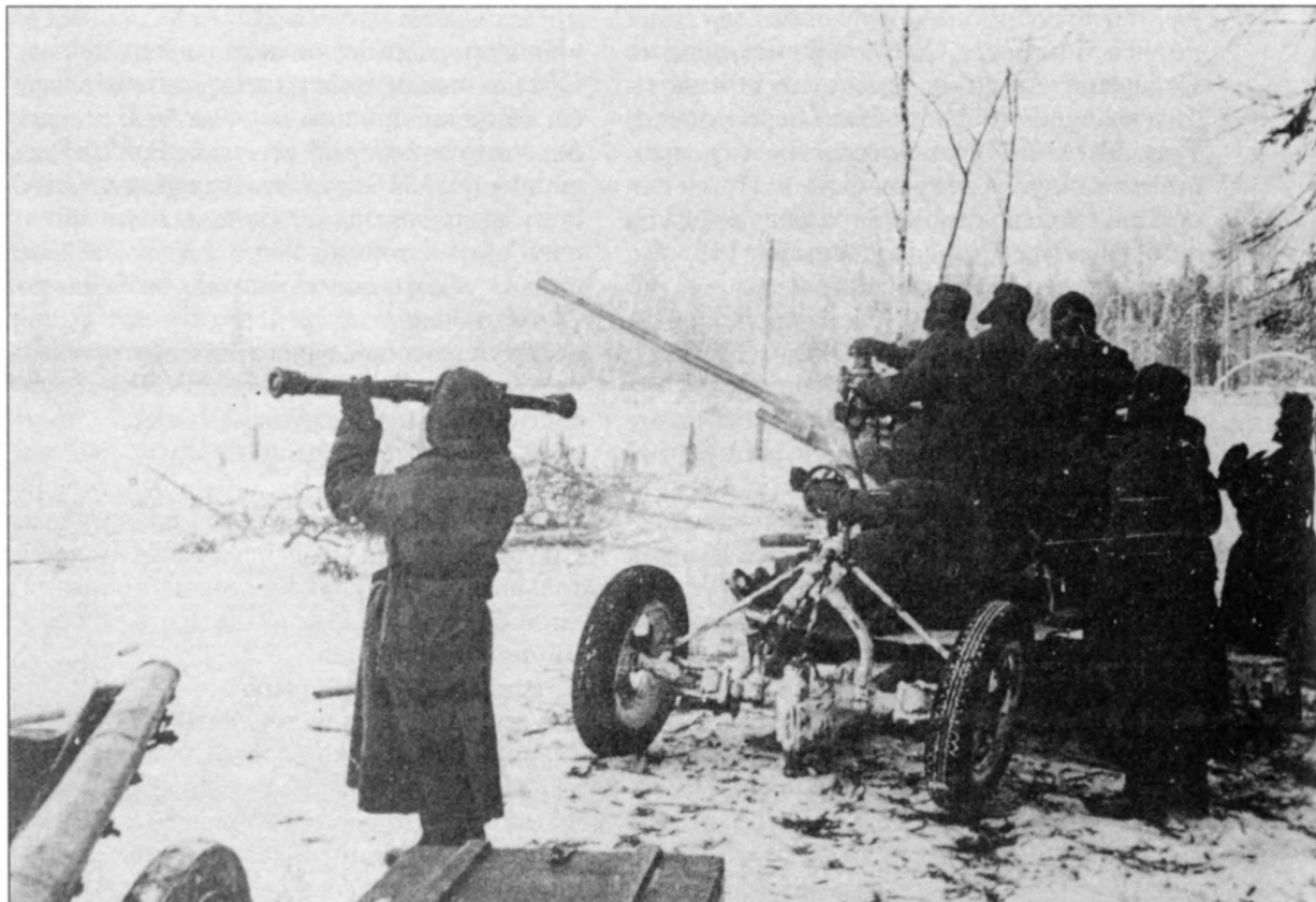
Расчет советского легкого зенитного орудия ждет, когда видимость в районе Мурманска улучшится. Солдат, стоящий слева от зенитки, держит в руках дальномер, с помощью которого определяли расстояние до цели
