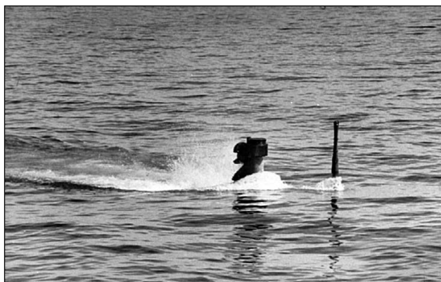
Подводная лодка типа XXI U-2513 идет под шноркелем
