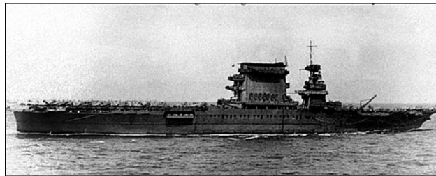
«Лексингтон» после попадания двух торпед. Размеры корабля скрадывают заметный дифферент на нос
