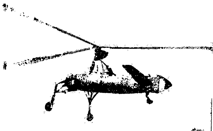
Фиг. 69. Автожир Лиоре и Оливье LeO-C-301, взлетающий без разбега.
