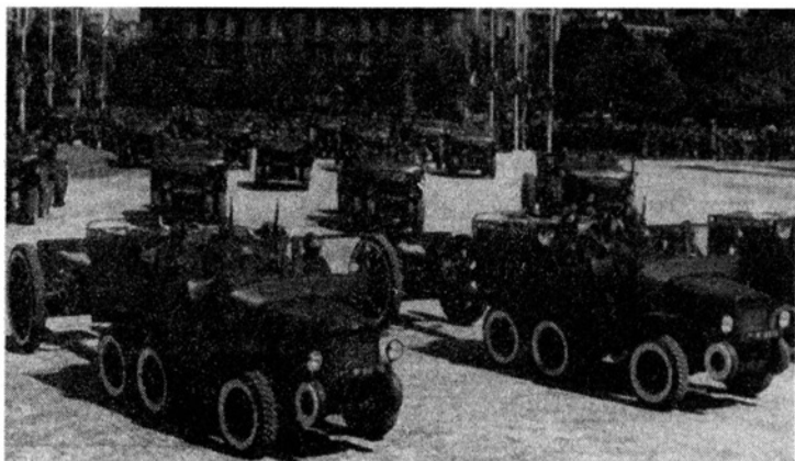
«Два мира, два детства»: На параде в День взятия Бастилии во Франции 75-мм пушки идут на буксире колесных тягачей «Лаффли» S15T (макс. скорость 51 км/ч)
