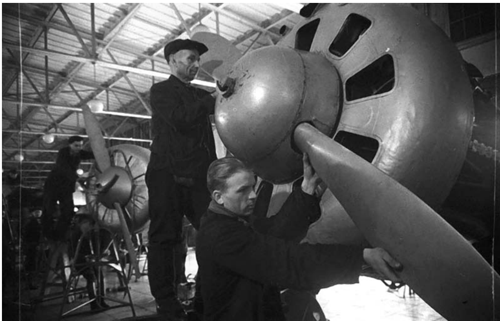
Сборка истребителей на авиазаводе
