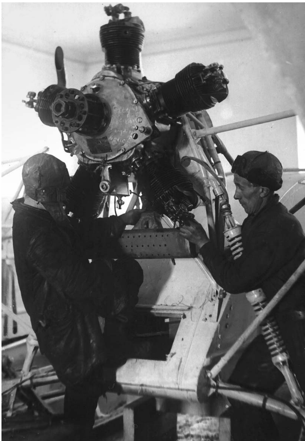
Установка двигателя на аэросани НКЛ-26 на архангельском заводе «Красная кузница»
