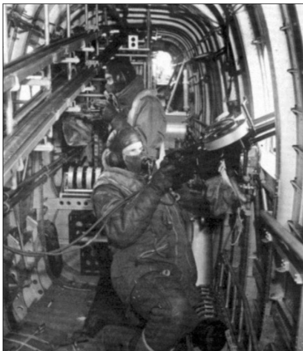
Стрелки бортовых установок «Галифакса» со спарками пулеметов «Виккерс»
