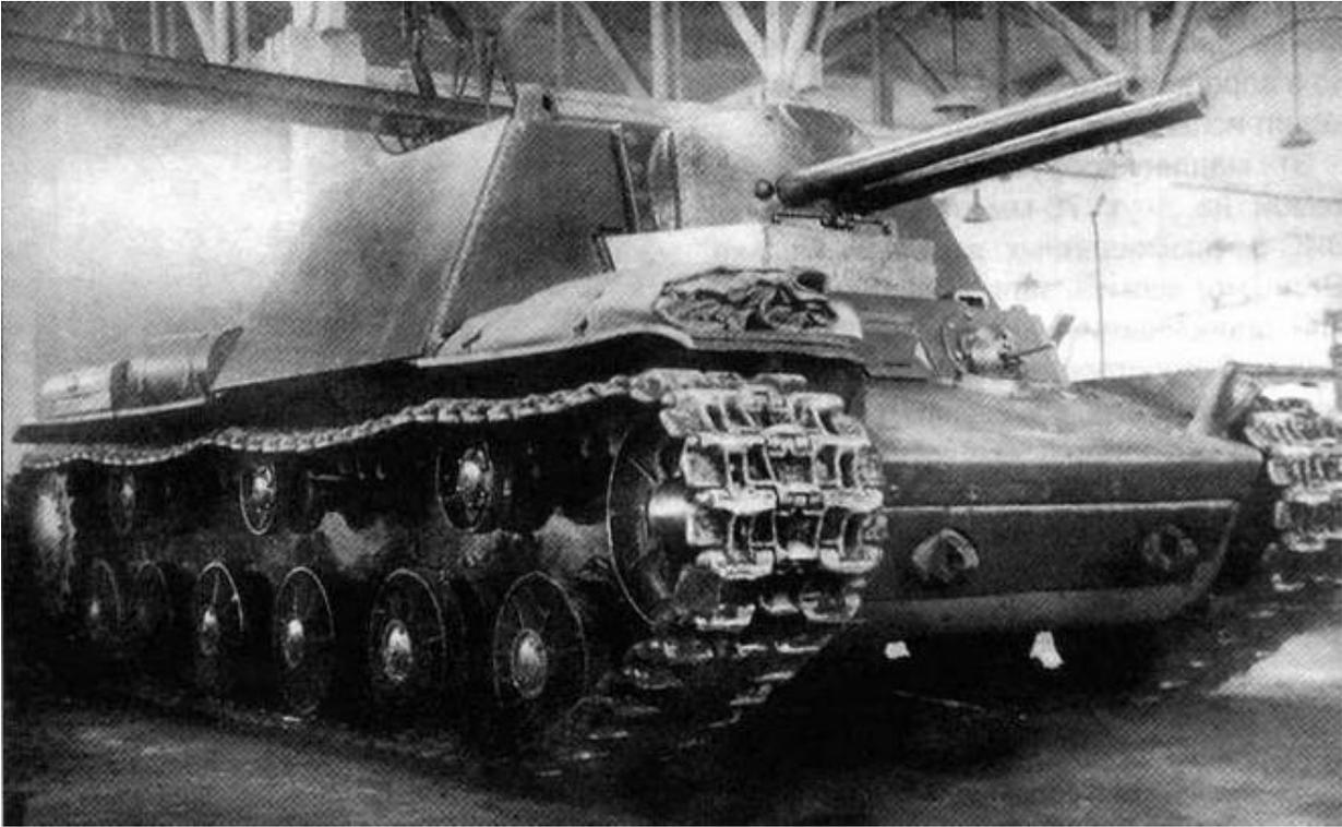
*Второй вариант КВ-7 (с двумя 76-мм орудиями) в цехе завода № 100. Челябинск, май 1942 года*
