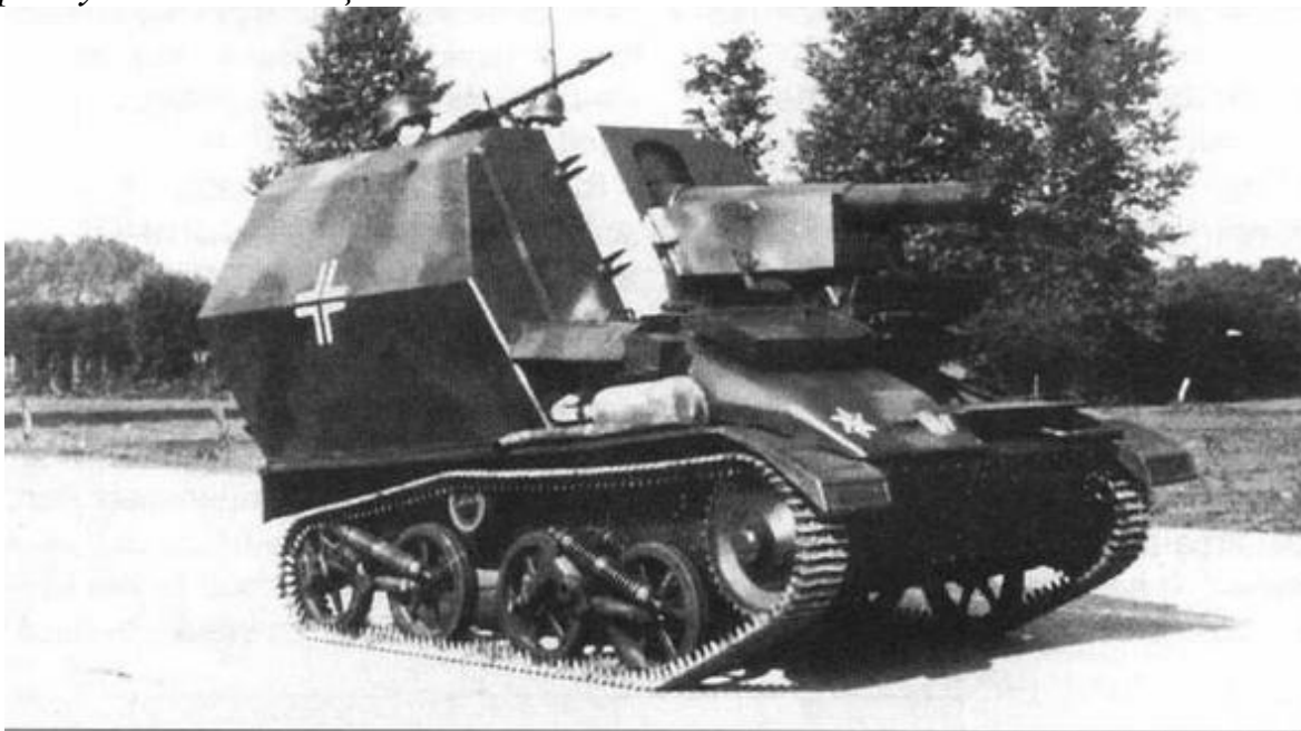
105-мм самоходная гаубица leFH 16 на шасси трофейного английского легкого танка Vickers Mk VI
