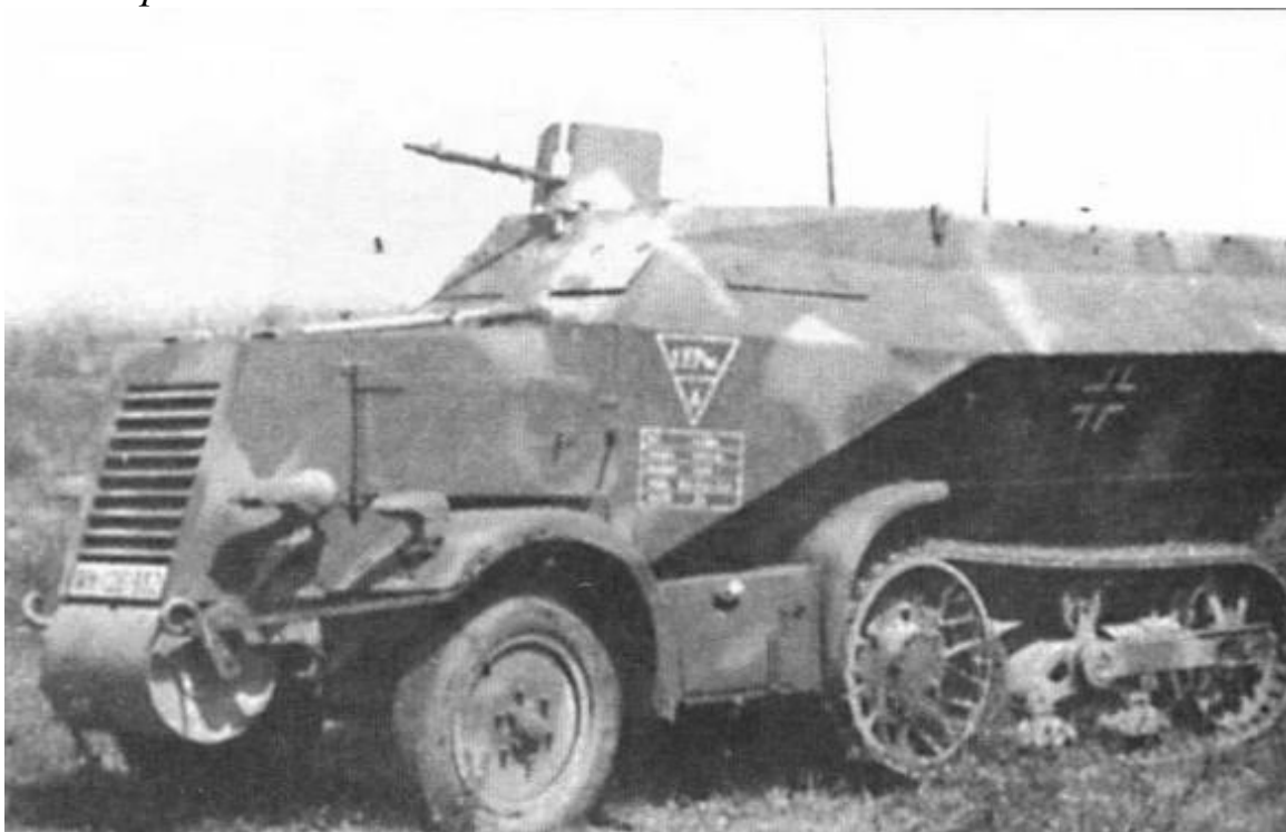
Легкие бронетранспортеры U304(f). Вверху — штабной бронетранспортер с двумя радиостанциями,
