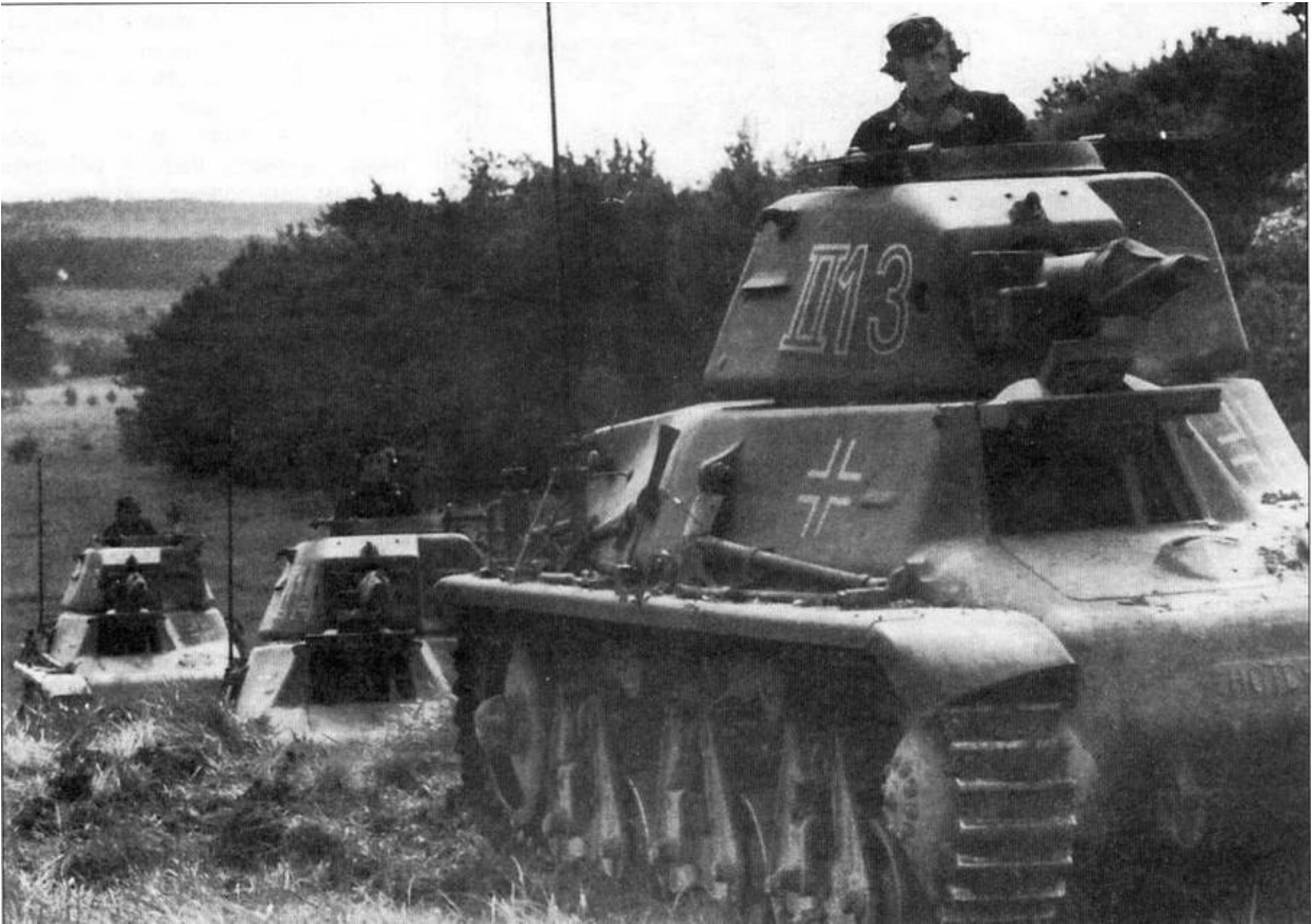
Танки 38Н(ф) 2-го батальона 202-го танкового полка во время учебных занятий во Франции. 1941 год. На всех машинах куполообразные командирские башенки заменены люками с двухстворчатыми крышками, установлены немецкие радиостанции
