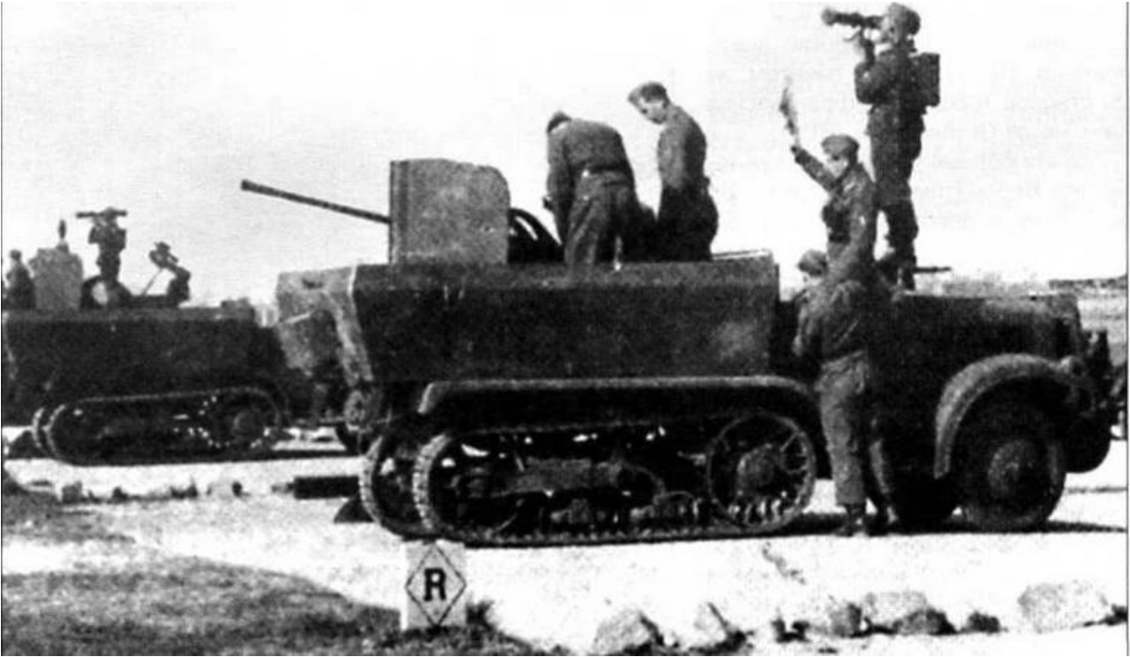
Батарея полубронированных ЗСУ на шасси U304(f) во время отработки учебно-боевой задачи. Франция, 1943 год
