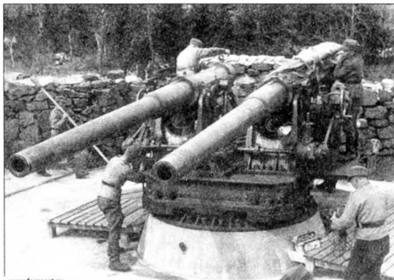
Двухорудийная 120/50-мм установка V2 на финской береговой батарее. Ранее эта установка находилась на мониторе Амурской флотилии, но была в 1915 г. снята и отправлена для усиления береговой обороны Финляндии
