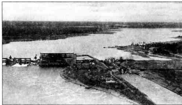
Разрушения шандоров (слева) и системы шлюза (справа) плотины Свирской ГРЭС. Вид со стороны нижнего бьефа (фото из архива О.А. Белайчука)
