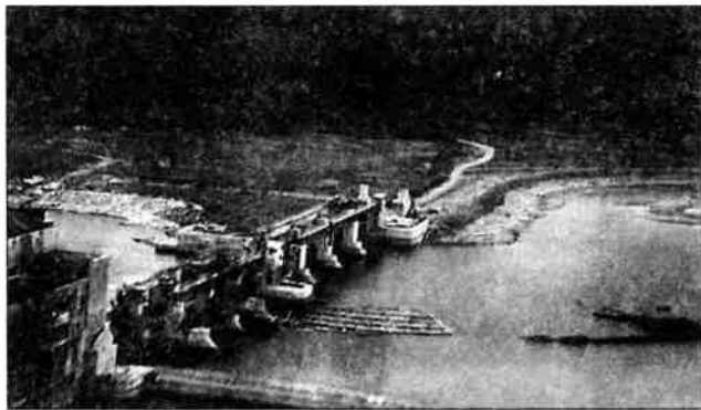
Разрушения шандоров плотины. Вид со стороны верхнего бьефа (фото из архива О.А. Белайчука)
