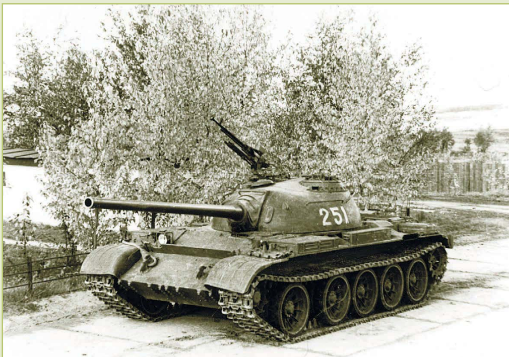
Танк Т-54 обр. 1951 г. выпуска 1953 года, оборудованный под установку минного трала ПТ-54
