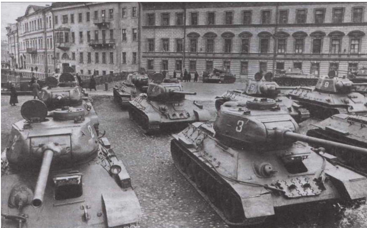
Танки Т-34-85 перед парадом. Ленинград, 7 ноября 1945 года. У машины слева хорошо видна характерной формы бронемаска пушки С-53
