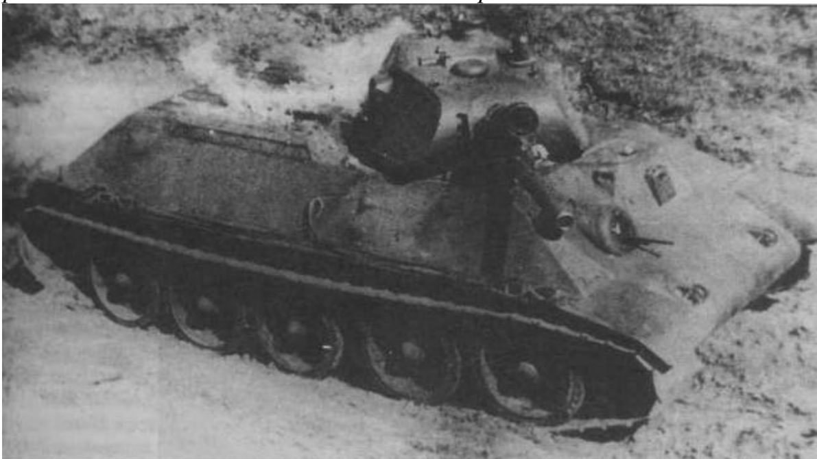
Второй опытный образец танка А-34 во время испытаний на пожароопасность. Весна 1940 года. Хорошо видна рубочка механика-водителя, имевшаяся только на этой машине
