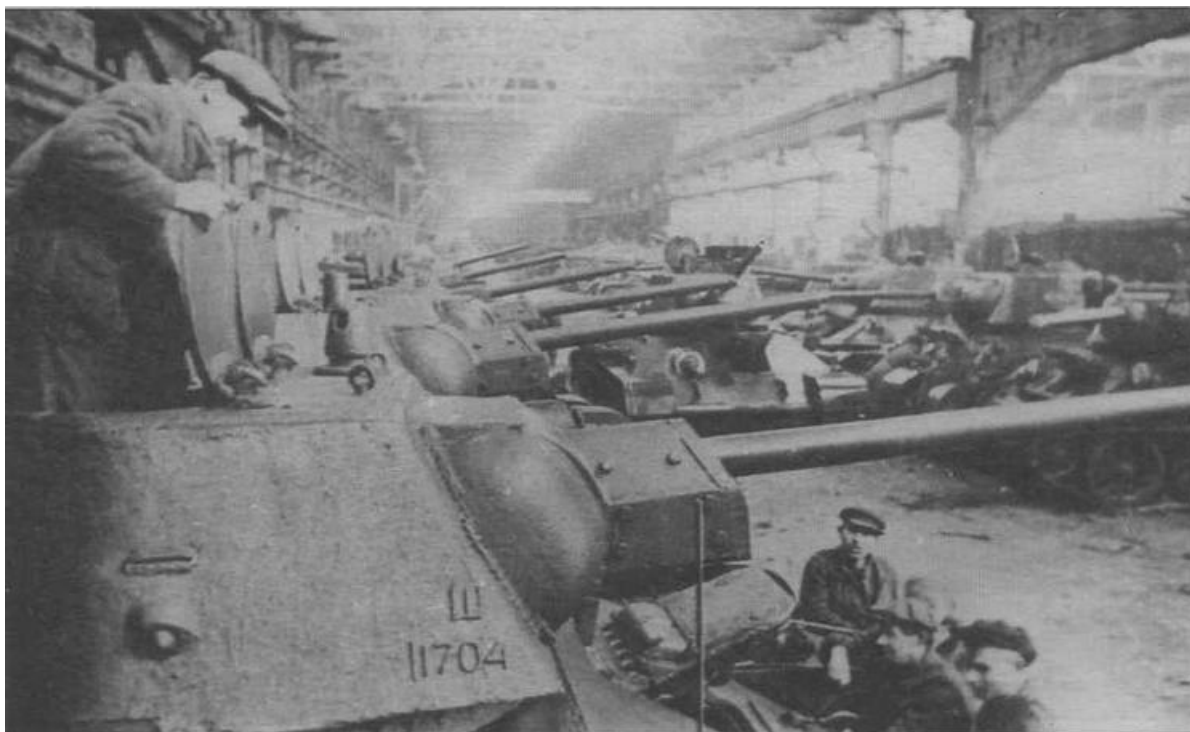
Последние доводочно-регулировочные работы на вновь изготовленных танках Т-34. Уралмашзавод, 1943 год
