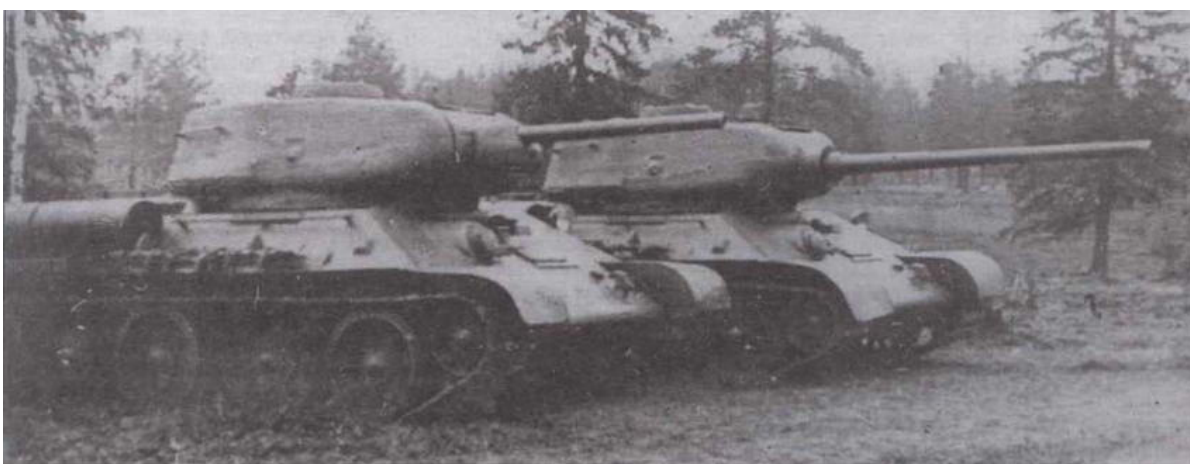
Танки Т-34 с башнями Т-43 с диаметром погона 1600 мм, вооруженные пушками Ф-34М и Д-5Т. Осень 1943 года
