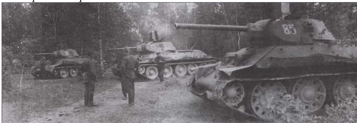
Танки Т-34 разных заводов и разных периодов выпуска. На переднем плане — машина производства СТЗ выпуска конца 1941 года с цельностальными опорными катками и необрезиненным направляющим колесом
