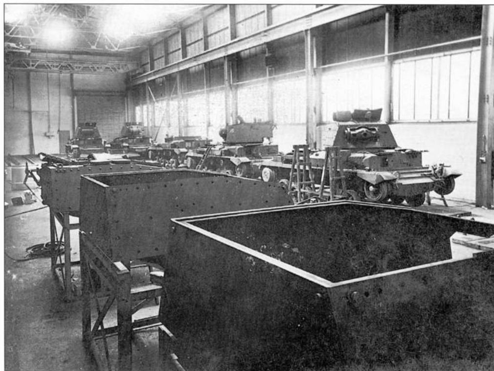
Сборка крейсерских танков Mk II в цехе завода фирмы BRCW, 1940 год. На переднем плане — стенды для сборки башен
