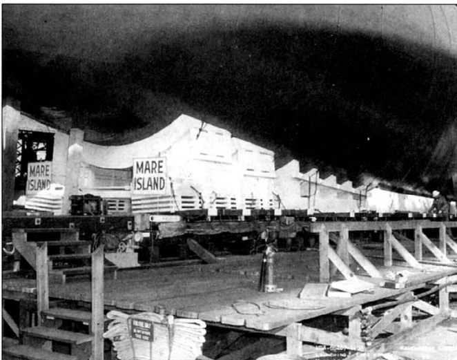
Передний ложемент, на котором установлена субмарина SSBN-642 «Камехамеха», 15 января 1965 г., верфь острова Мари.
