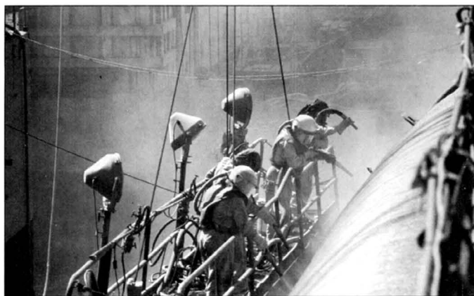
Четверо моряков пескоструями чистят корпус атомохода. Работы производятся только в спецодежде после проведения обязательно инструктажа по технике безопасности.
