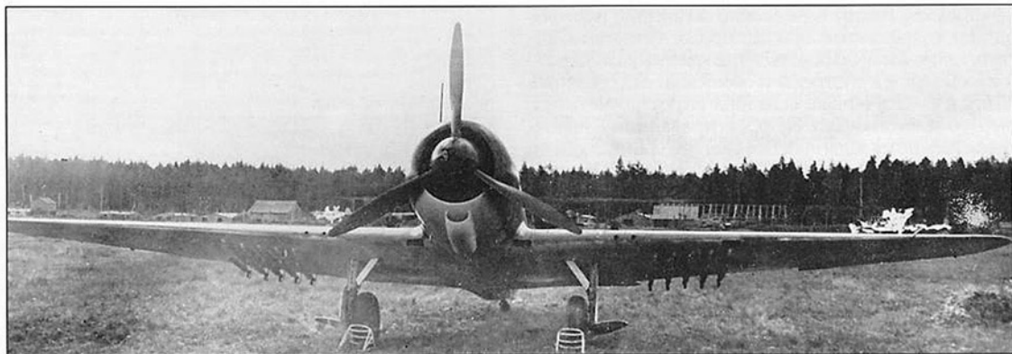
Самолет Су-2 № 13016 с десятью подвешенными под крылья ракетами РС-132 на испытаниях в НИПВ. Airplane Su-2 № 13016 with ten RS-132 rocket projectiles under wings on trials in NIPAV (Research range of an aircraft armament).
