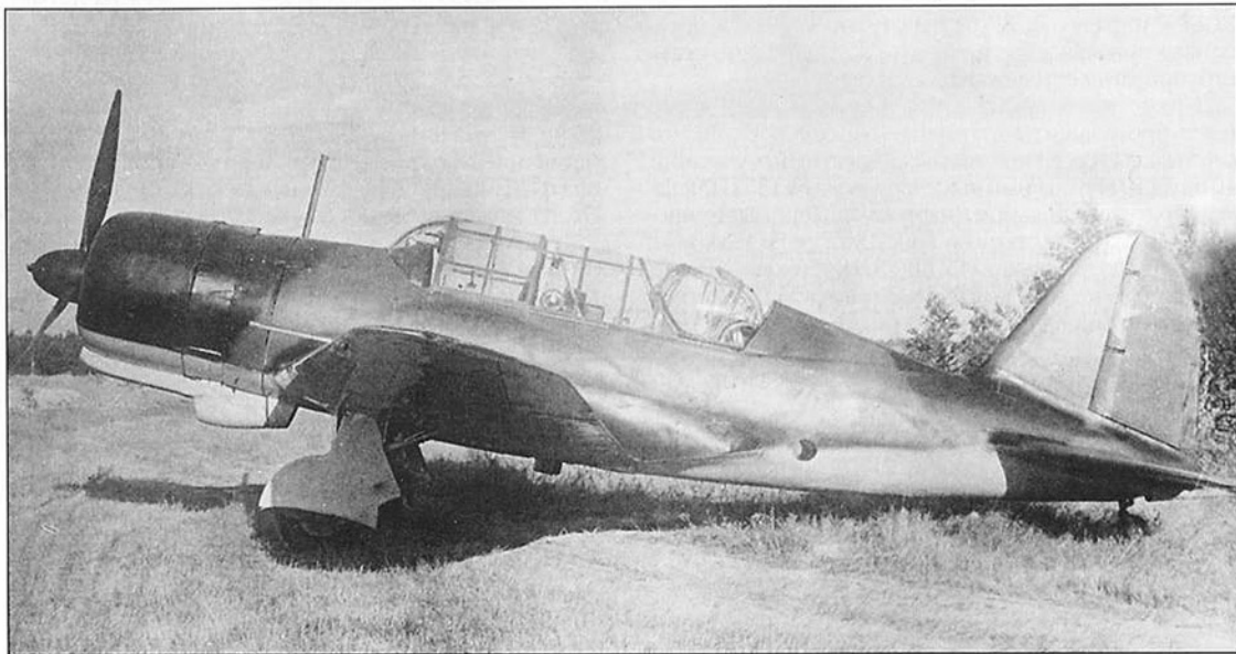
Тот же самолет с опущенной турелью. Same airplane with a lowered turret.
