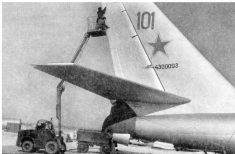
Осмотр вертикального оперения самолета №430003 с помощью наземных средств обслуживания
