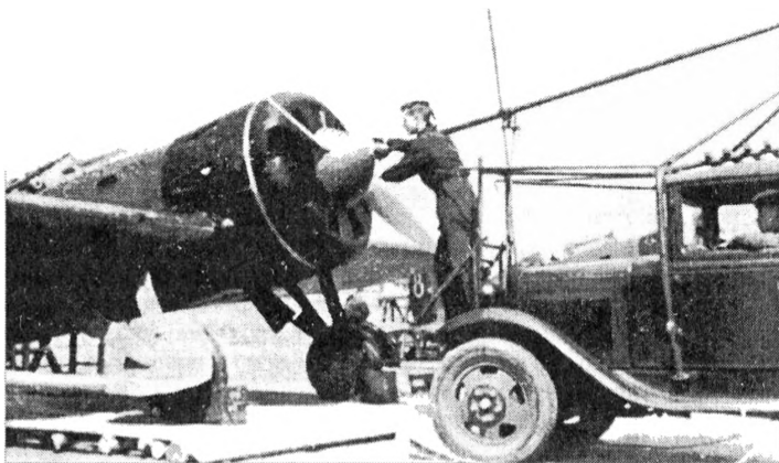
Так происходил запуск авиационного двигателя с помощью автомобильного стартера
