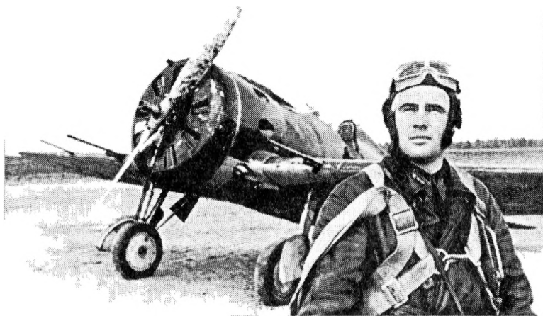
Летчик 191 ИАП ст. лейтенант Г.С. Жуйков и его самолет — истребитель И-16 тип 17, оснащенный двумя крыльевыми пушками ШВАК. Ленинградский фронт, сентябрь 1941 г.
