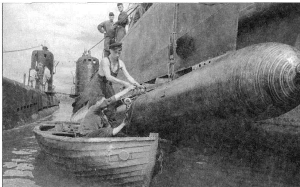
Заряжание торпеды в торпедный аппарат подводной лодки XII серии. Черноморс- кий флот (справа и на с. 55)
