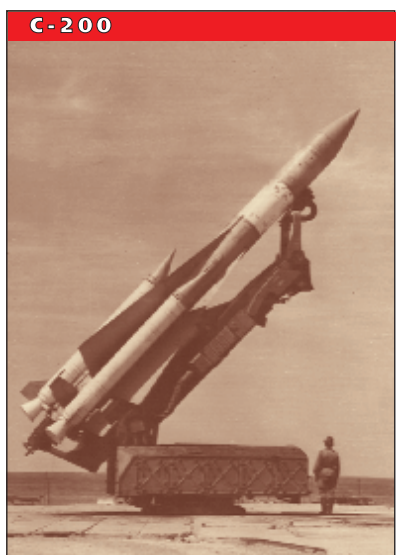
Ракета на пусковой установке зенитно-ракетной системы большой дальности действия С-200
