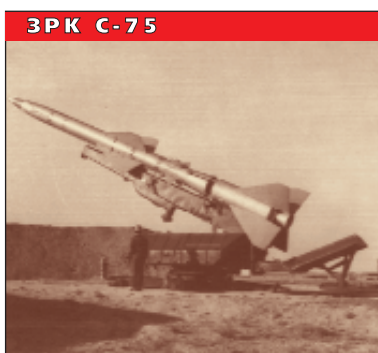
Радиоуправляемая зенитная ракета ЗРК С-75
