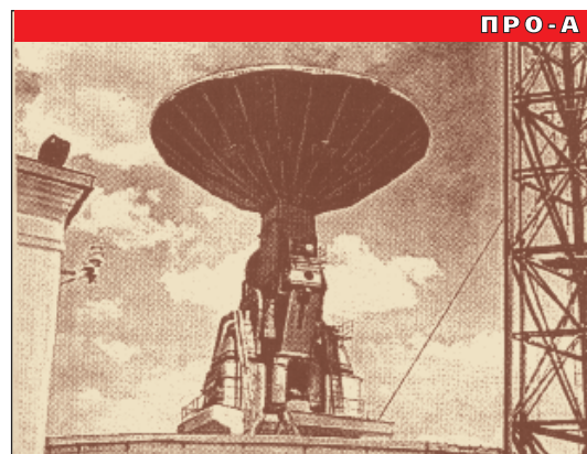
Антенная система радиолокатора точного наведения антиракеты системы ПРО «А»
