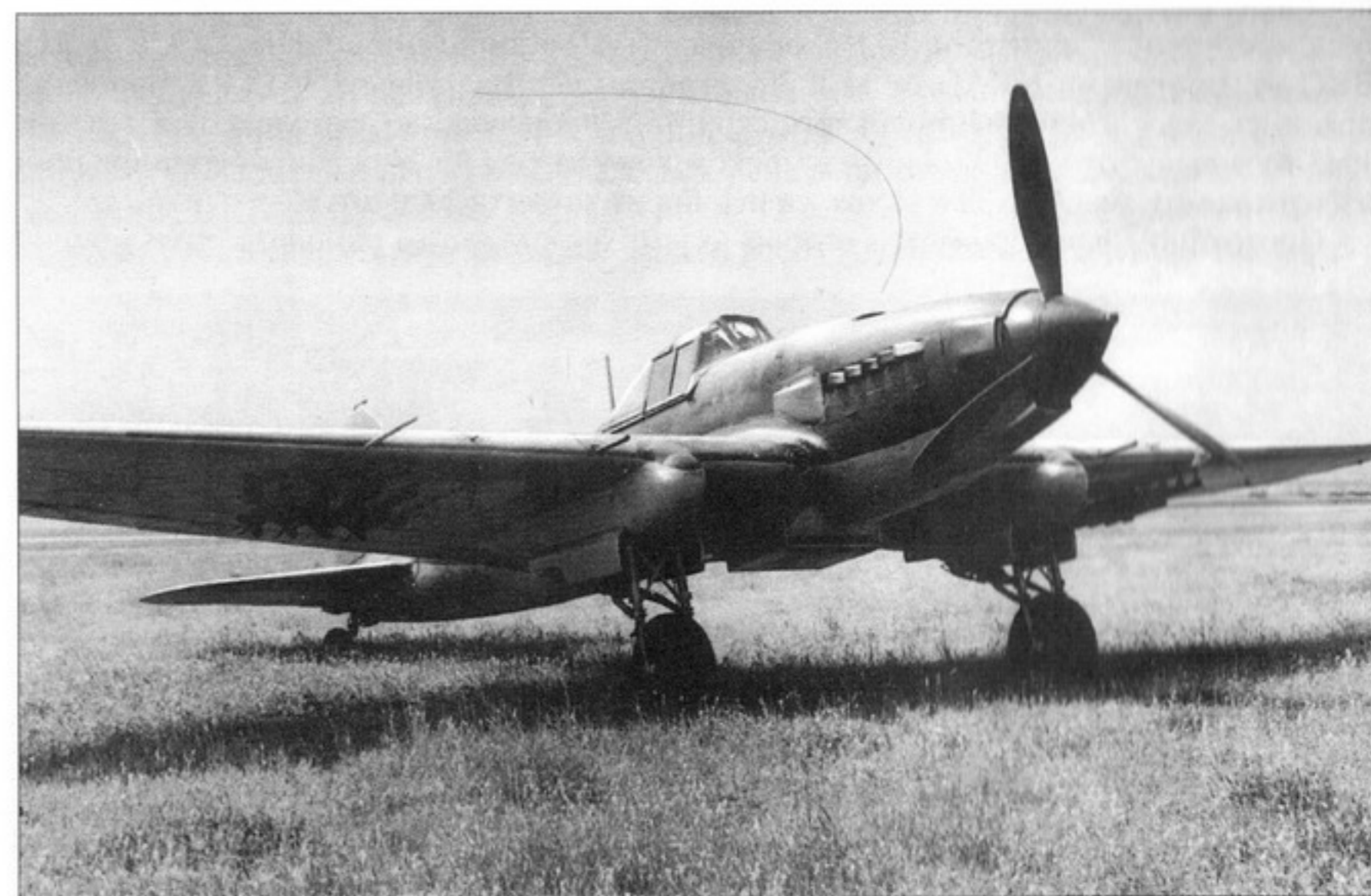
Серийный штурмовик Ил-2 с пушками. В носке центроплана у правого бока виден заборник всасывающего патрубка двигателя. Под крылом подвешены 8 РС-82.
