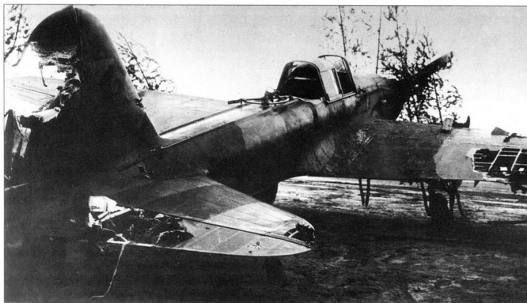
Одноместный штурмовик переделанный в двухместный в фронтовых условиях. Видна самодельная рама крепления пулемета и отверстие в задней части фонаря для стрелка. Вдоль фюзеляжа прикреплены два лонжерона из металлических профилей, усиливающих жесткость хвостовой части при повреждениях фюзеляжа.
