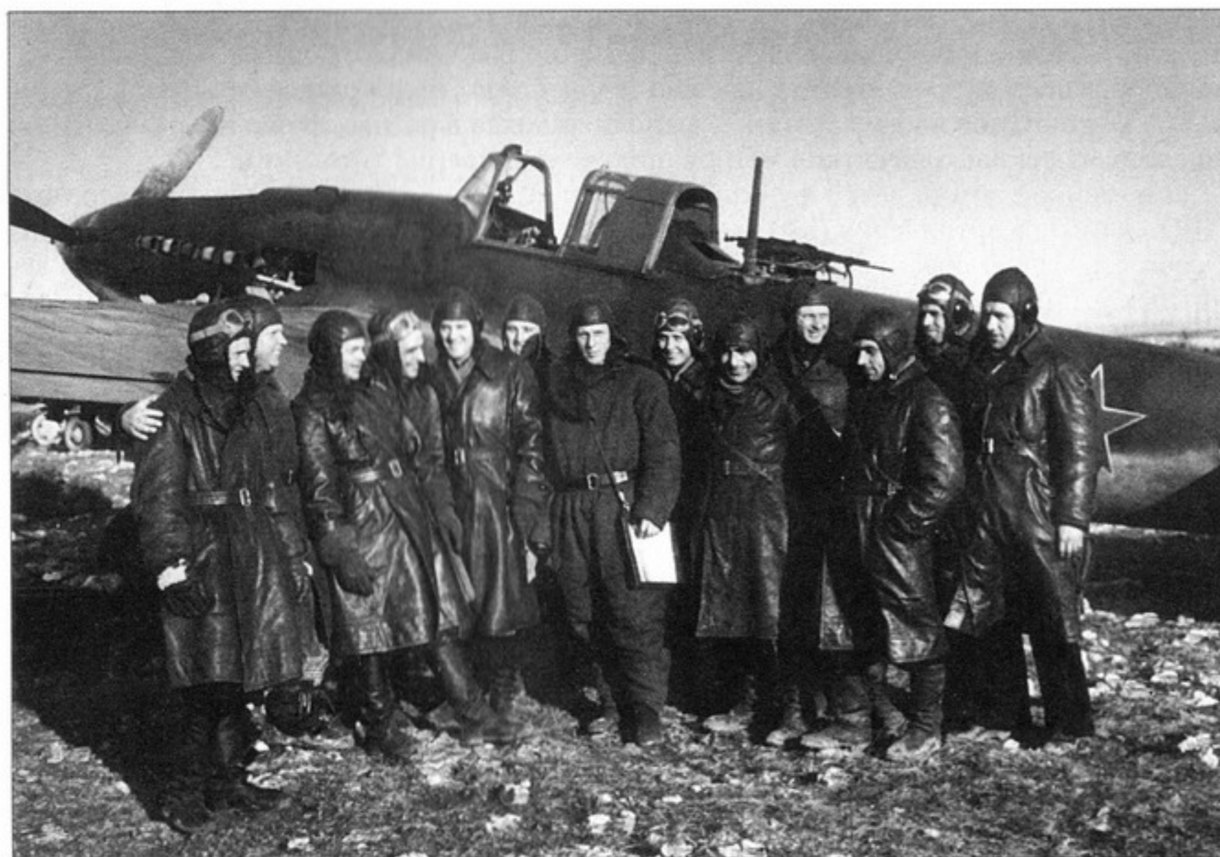
Группа летчиков штурмового полка Героя Советского Союза Губрия. Одноместный штурмовик с прицелом ПВП-16 и и зеркалом заднего вида на козырьке имеет вырез в заднем обтекателе фонаря для размещения воздушного стрелка и оборонительный пулемет на самодельной установке. Кавказский фронт, весна 1942 г.
