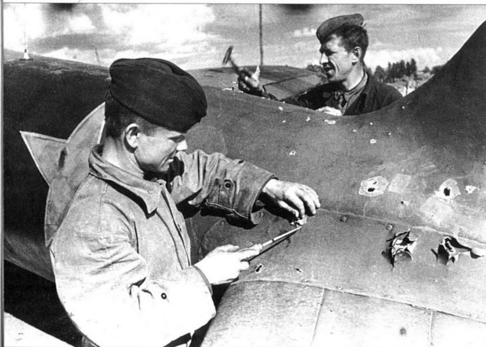
Самолеты возвращались на свои базы, имея по 10-20, а иногда и более, пробоин. Поврежденные машины в самый короткий срок восстанавливались силами полковых ремонтных служб.
