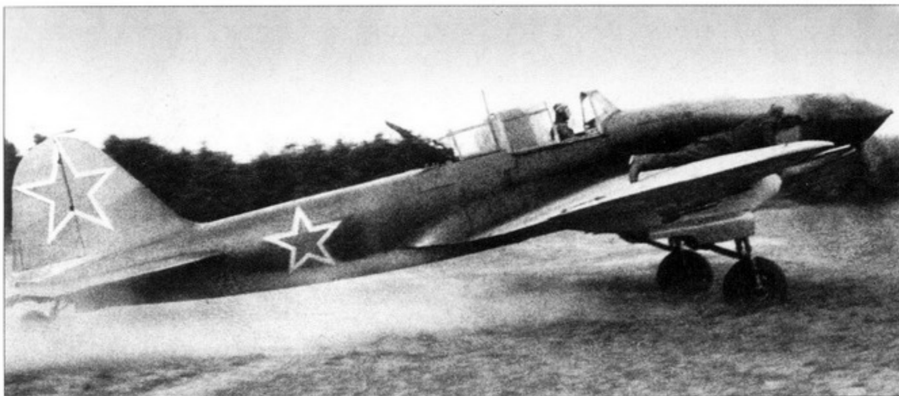
Самолет выруливает на старт. Техник, лежащий на крыле, наблюдает за работой двигателя.
